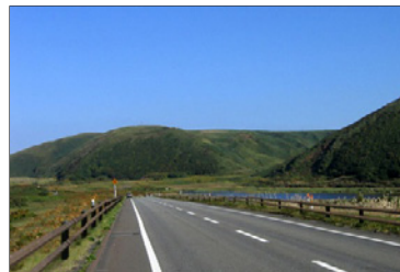
木製ガードレールの評価が高かった景観の例（写真コ）
