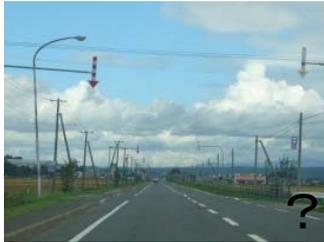
郊外部や山地部など沿道両側への供給が少ない区間では、電力柱とNTT柱を集約して人工構造物の削減を図ることが望ましい。
