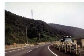
尾根や谷を周囲と連続させて造形した直後(左)とその30年後の姿(右)。連続する切土に対し、地山の起伏に合わせ尾根と谷を明確に意識した丸み付けを行っている。現在では植生も回復し、そのような地形が元々あったかのような「新しい山」が形成されている。
