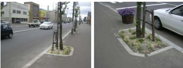
・積雪地タイプ支柱(R12美唄峰延)従来からタイプは樹木と接木部で結束であるが、積雪タイプは支柱部で結束する。
