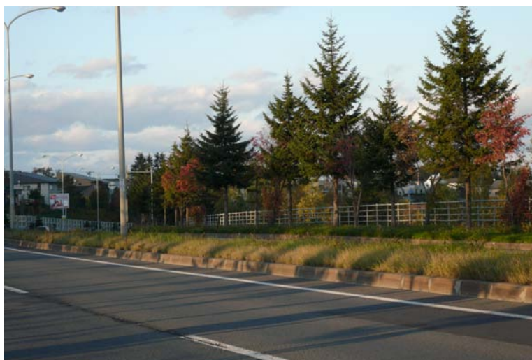
写真 1-1 環境施設帯の常緑樹針葉樹植栽
