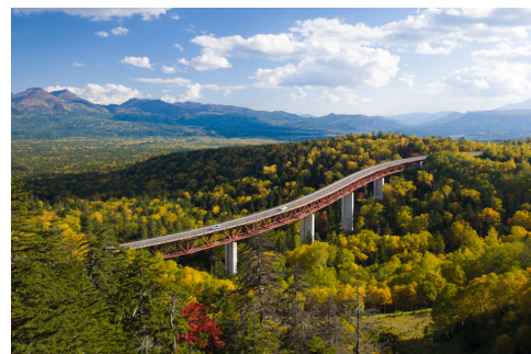
▲雄大な自然と橋梁の対比が美しい (国道273号三国峠)
