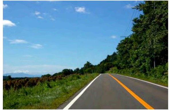
写真－6 電線電柱類の片寄せによる景観向上効果
