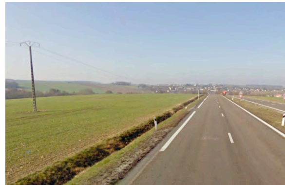
写真－7 フランスにおける大規模なセットバック事例
