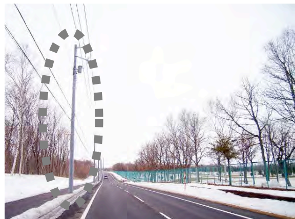
写真-4 歩車道境界付近に電柱が設置された事例 交通事故等の危険性がある
