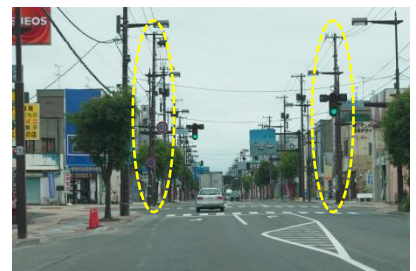
写真3 調和していない茶系塗装の電柱
