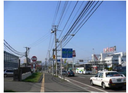
写真1 電線多線化の事例
