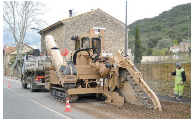
写真-2 掘削機械による郊外道路施工事例 13) (イタリア)
