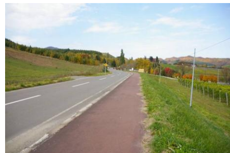
写真-16 コース沿いのカラー舗装(富良野フットパス)
