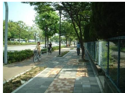
写真-13 柵によらない自転車走行帯を分離 21)
