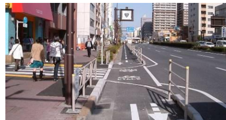
写真-8 車道部で柵と縁石により分離 20)
