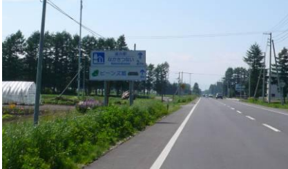
写真-3 自転車通行が可能な路肩拡幅の事例 (R236号中札内村)
