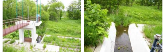
写真-2 樋門により河川敷における移動の連続性が確保されていない例
