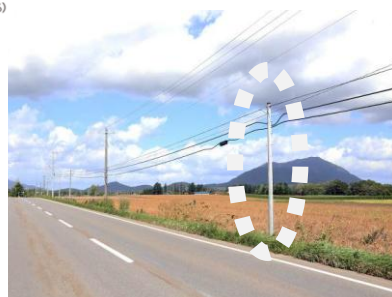
写真-2 通信線の増加に伴い通信用の電柱が増設された事例
