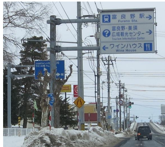
写真-7 標識が隠れている事例
