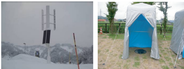
写真-10 左：平時はも有効な太陽光と風力発電の照明 右：マンホールを使用する非常用トイレ
