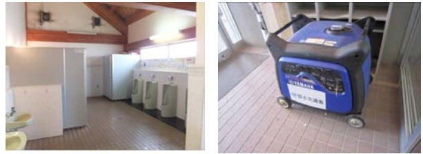
写真-12 左: 停電時でも日中は明るい自然光のj入るトイレ 右: 日常のイベントにも活用できる自家発電機
