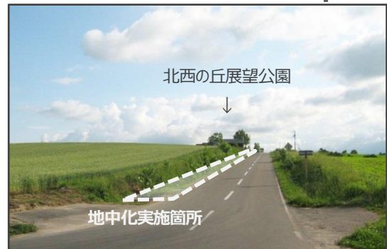
写真-2 美瑛町の農村域での電線類地中化実施箇所(写真の道路左側・実施後)
