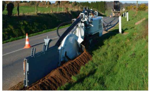
写真-10 海外における専用機械による施工例 ホームページより引用 11)
