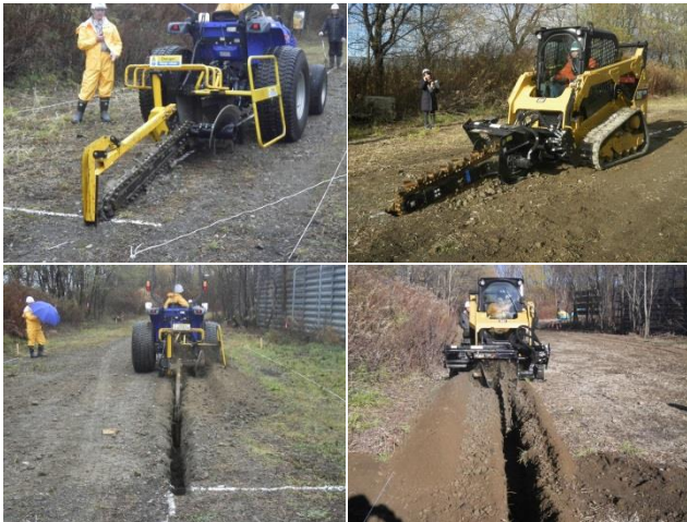
(左:掘削機械A、右:掘削機械B)
