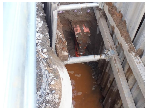
写真-5 掘削地盤内の出水状況
