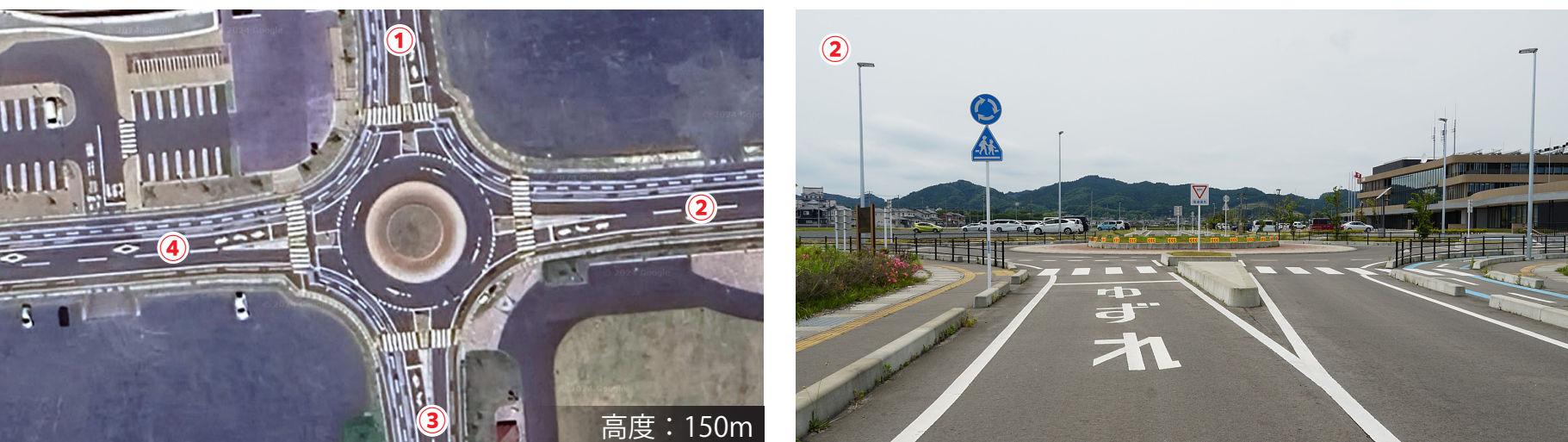
▲ ID25:宮城県亶理町(F:田園地区型)亶理町役場、防災広場の一体整備
