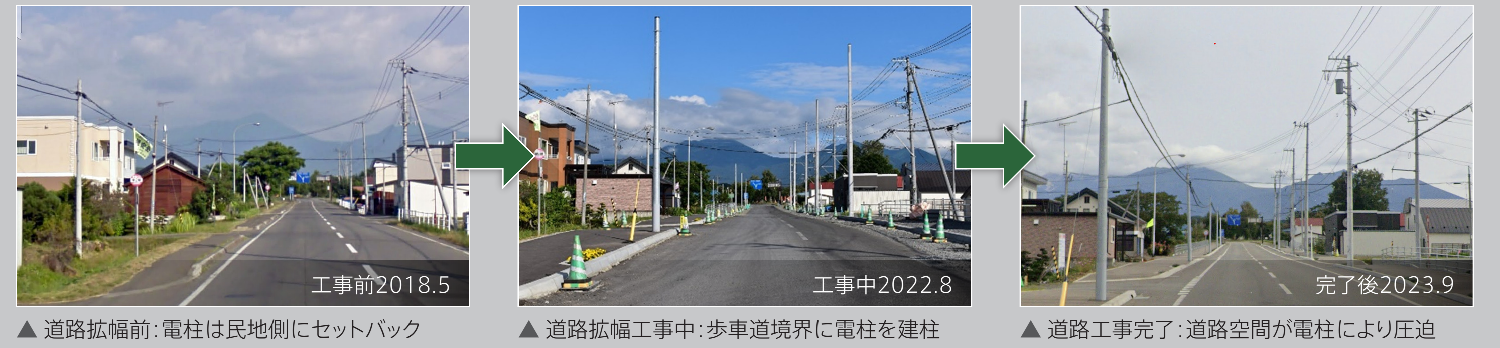
▲ 道路拡幅前:電柱は民地側にセットバック ▲ 道路拡幅工事中:歩道境界に電柱を建柱 ▲ 道路工事了:道路空間が電柱により圧迫
