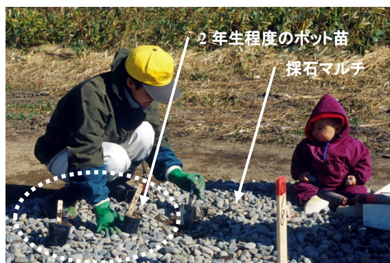
写真 2-8 生態学的混播混植法の植付け状況
