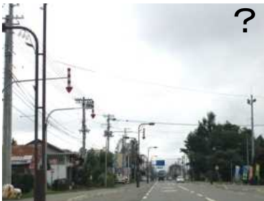
固定式視線誘導柱と道路照明
