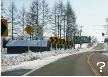
緩やかなカーブ区間で重なって視認されるシェブロンマーカ―
