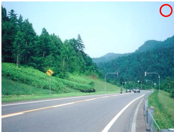
R230無意根大橋付近の緩勾配切土
