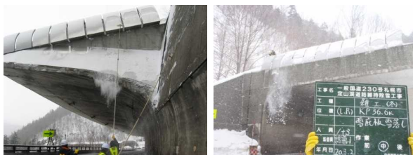
雪庇防止板の雪落とし作業
