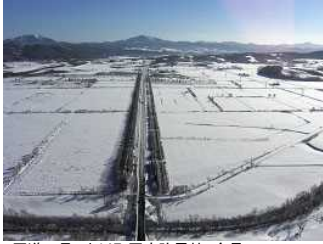
・国道40号 中川町国府防雪林 全景
