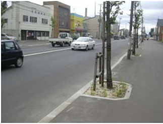
・積雪地タイプ支柱(R12美唄峰延)従来からタイプは樹木と接木部で結束であるが、積雪タイプは支柱部で結束する。
