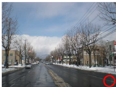
・電線巻込型(函館)
