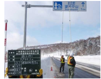
道路標識の雪落とし作業
