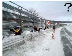
毎年のように発生する防雪柵の除雪 防護柵によって雪堤がある区間での視程障害
