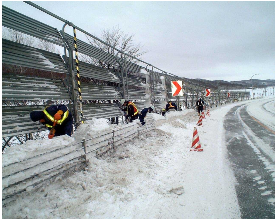
吹き払い式防雪柵下部の除雪作業
