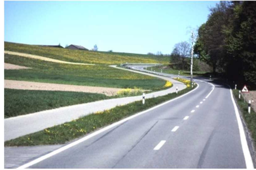
視線誘導はドイツと同様に木製を採用。 (土木学会付属土木図書館 伊藤清忠景観デザイン・フォトライブラリー)
