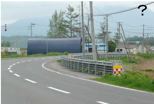
折りたたみ式では、景観向上効果も限定的？衝突事故の問題やその対策で反対車線にまでクッションドラムが付き景観が悪化する。(派手な色のドラムは本当に必要なか？)
