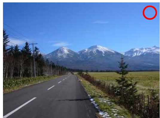
林のある側に電柱を片寄せし、美しい眺めを創出した例
