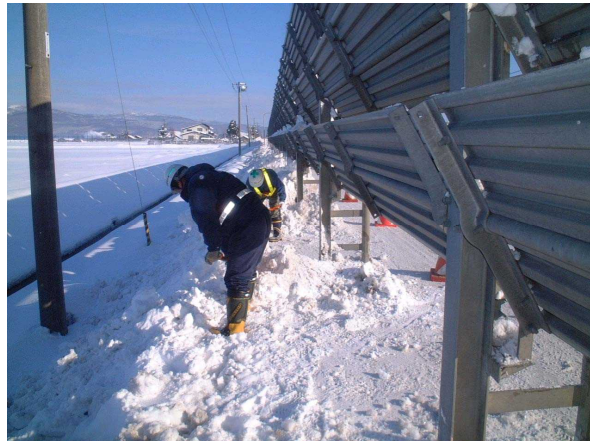
吹き払い式防雪柵下部の除雪作業
