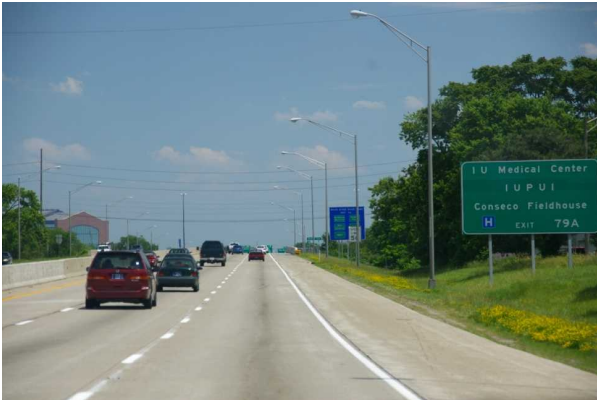
海外では一般的な路側式案内標識、前方の景観阻害が小さい
