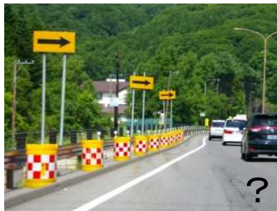
車線減少箇所でガードケーブルの前に視線誘導施設を設置した結果、その前にガードレールとクッションドラムを設置している事例（路肩直近に視線誘導施設を設置したことによる負の連鎖）
