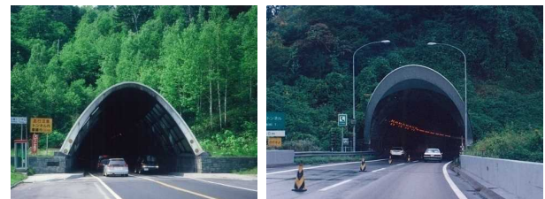
突出型坑口(国道230号)
