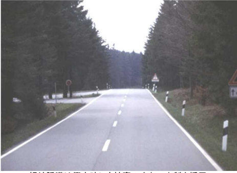
視線誘導は衝突時にも被害の少ない木製を採用。 (土木学会付属土木図書館 伊藤清忠景観デザイン・フォトライブラリー)
