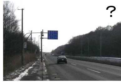
バスベイに矢羽根を設置した場合、除雪作業には有効だが視線誘導にはかえって分かりにくくなる。(特に夜間)
