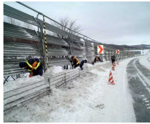
防護柵と防雪柵の間の人力除雪
