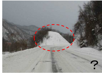
のり面と地山が鋭角に交わり、先鋭的な印象を与える。 このような場合には、クレストラウンディングを行なうことを検討する。
