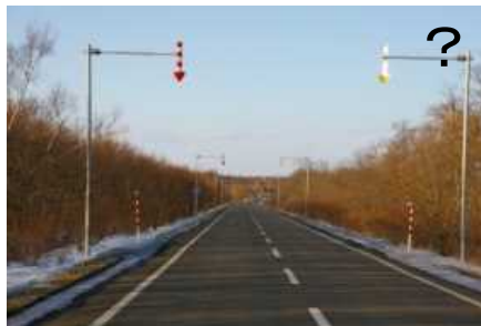
伸縮式視線誘導標を設置して維持管理されていることから矢羽根が不要？と考えられる事例。(10年確率最大積雪深 約70cm)
