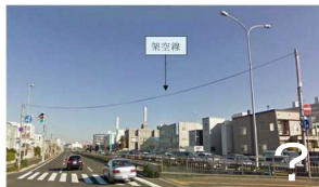
無電柱化されているが、架空戦が道路を横断しており、景観を阻害している。(出典：資料1)
