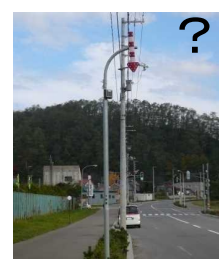
緑石背面に電柱や標識類が連続設置されている箇所での矢羽根の事例。視線誘導が必要だとしても、伸縮式視線誘導標で十分では？
