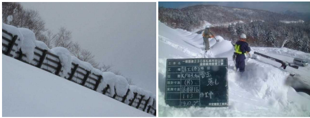
雪崩防止柵の雪降ろし作業
