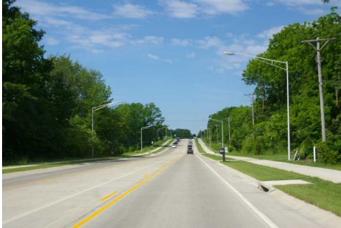
歩車道分離帯の十分な緑地と附属施設のセットバック
