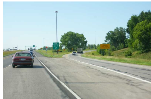
防護柵のない道路分岐
