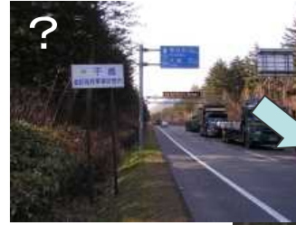
F型柱に情報板・2本の案内標識・管理区分標識を集約化することで、景観が保全された事例
