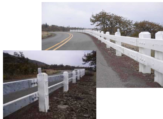
梁の裏面に鋼板を設置した木製防護柵
