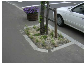
・積雪地タイプ支柱(R12美唄峰延)従来からタイプは樹木と接木部で結束であるが、積雪タイプは支柱部で結束する。
