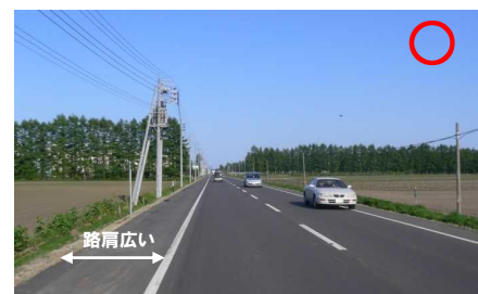
道路改良により拡幅された路肩(中札内村)
