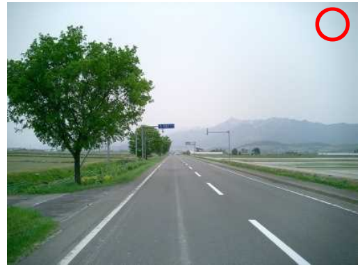
適度な間隔の植樹により効果的に電柱を遮蔽している事例
