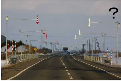
除雪管理用の伸縮式視線誘導標と視線誘導も兼ねた矢羽根の併設している事例。 (10年確率最大積雪深 約80cm)。
