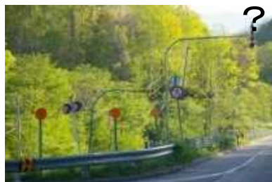
視線誘導標とシェブロンが同時に設置された事例
