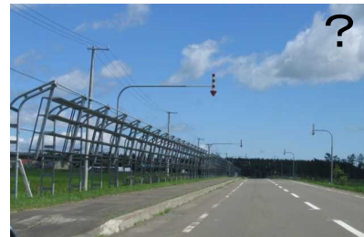
防雪柵設置区間に矢羽根が併用されている事例。 (矢羽根基礎部の位置から防雪柵設置に合わせて再設置か？)
