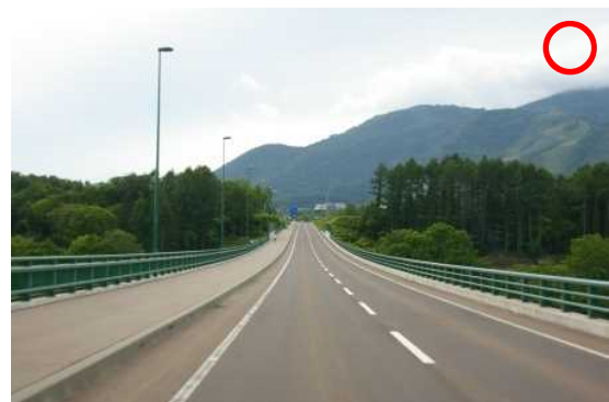
高欄の外側に照明柱を設置し、開放的な景観を形成している事例
