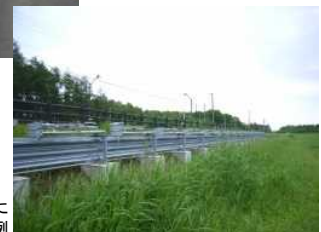
防雪柵を盛土の低い位置に設置した事例
