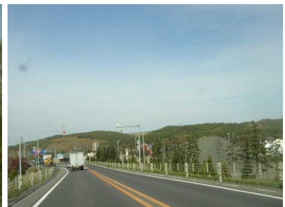
・碎石場 国道237号 美瑛
