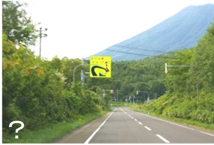
急カーブを注意喚起する標識に蛍光色が採用された事例
