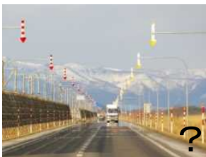
矢羽根と伸縮式視線誘導標が同じ区間に併用された事例 視線誘導効果の競合やコスト面で併用は適さない。(道路吹雪対策マニュアル(平成23年改訂版))
