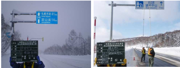
道路標識の雪落とし作業
