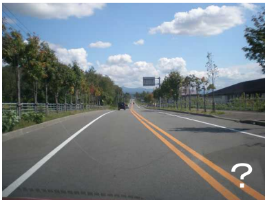
・適切な植栽配置、間隔か？(郊外部であるのに市街地と同じような位置、間隔)
