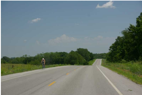
道路附属施設が設置されていない道路
