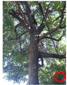
電線に鞘管を設置している例
