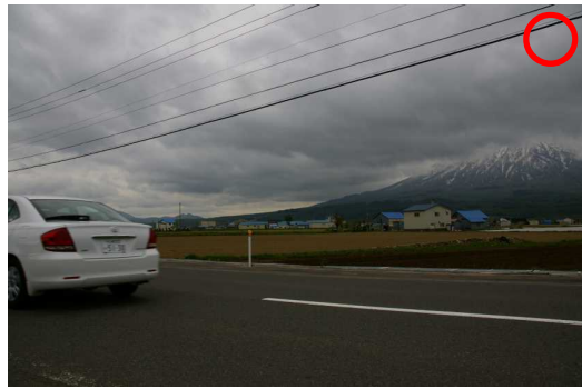
完全収納式では、路側がすっきりする。夏にはジャガイモ畑の花が咲くと近くから見える。矢羽根もデリネーターに変更。
