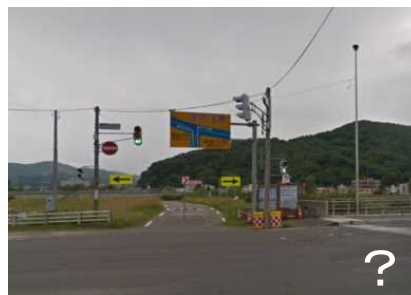
暫定供用の際に多いT字路は、特に、過剰に標識類が設置されやすい。(出典：Google ストリートビュー)
