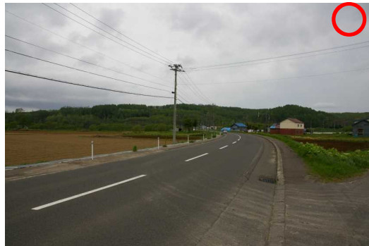
完全収納式では、路側がすっきりする。矢羽根もデリネーターに変えて景観対策効果が出ている。
