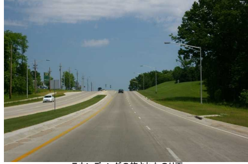
ラウンディングの施されたのり面
