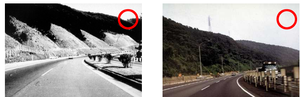
尾根や谷を周囲と連続させて造形した直後(左)とその30年後の姿(右)。連続する切土に対し、地山の起伏に合わせ尾根と谷を明確に意識した丸み付けを行っている。現在では植生も回復し、そのような地形が元々あったかのような「新しい山」が形成されている。
