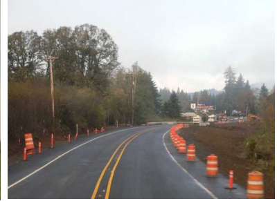
画一的に整形しないのり面の造成 (ドーコン・フォトライブラリー)
