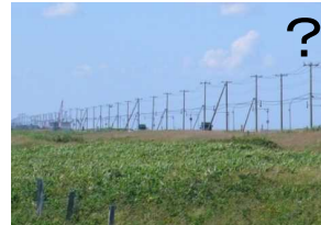
乱立する道路の柱類
