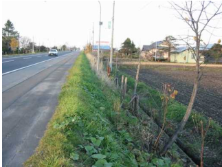
・雪圧防止杭(R12 美唄)手前は杭なしの状況
