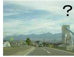
・工場 国道237号 富良野
