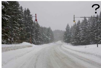
沿道の自然林により防雪効果が期待できる区間に矢羽根と伸縮式視線誘導標が併設されている事例。
