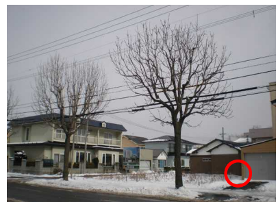
・電線巻込型(函館)
