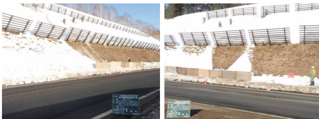
法面の人力除雪作業
