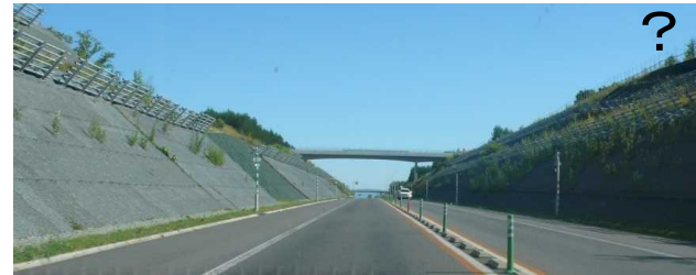
コンクリートのり面と雪崩防止柵による堅く冷たい人工的な印象の道路景観
