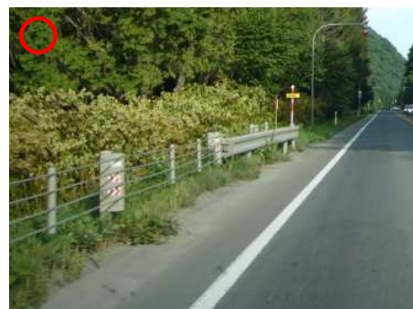
ガードケーブルの端部処理（ガードレール）によりクッションドラムを設置していない事例
