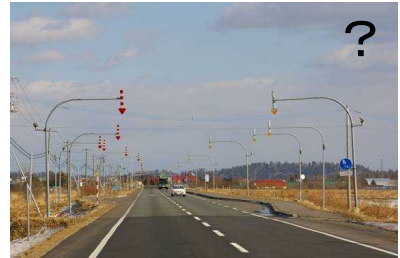
バスベイに矢羽根を設置した場合、除雪作業には有効だが視線誘導にはかえって分かりにくくなる。(特に夜間)
