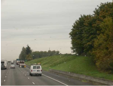
ラウンディングと修景植栽(ドーコン・フォトライブラリー)
