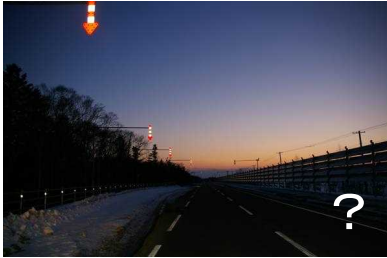
バスベイに矢羽根を設置した場合、夜間にはカーブ区間とも見える場合がある。
