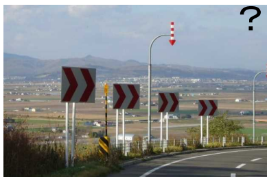
ビューポイントにおいて、防護柵直近に設置した矢羽根の事例。 スノーポールとともにシェブロンが併用されている。
