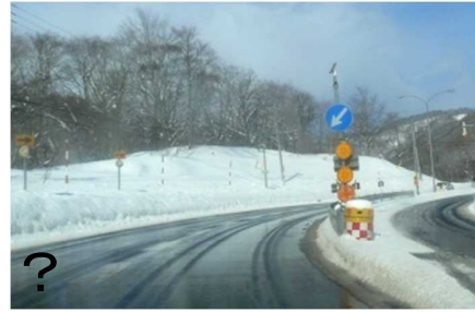
中央分離帯に標識・大型の反射板・クッションドラムが連鎖的に整備されている事例
