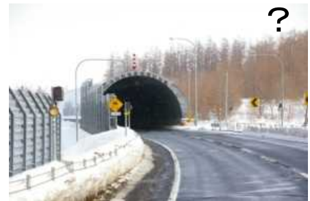
防護柵に自発光式デリネータを設置して維持管理されていることから、矢羽根が不要と考えられる事例。
