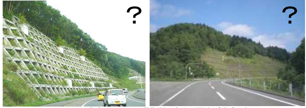
フリーフレームや急勾配によって長期間にわたり樹木が生育しないのり面
