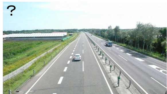
広幅員化せず中央分離帯に防護柵を設置した事例
