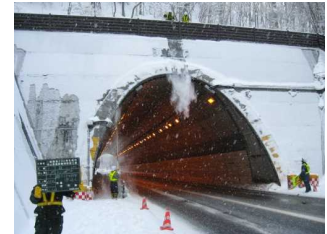
トンネル坑口の雪落とし作業
