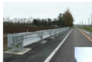
防雪柵を盛土の低い位置に設置する例
