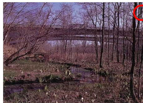
道央自動車道ポロ橋
