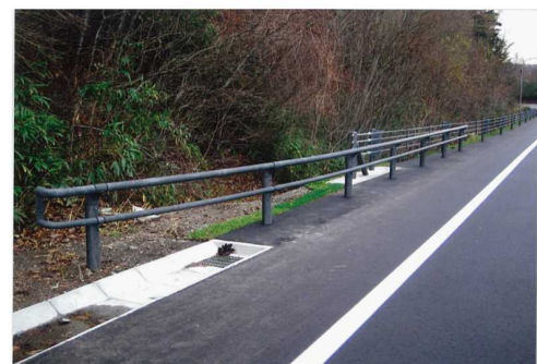
末端部にガードパイプを用いた事例
