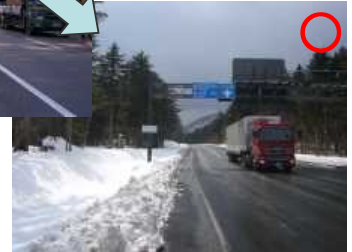
F型柱に情報板・2本の案内標識・管理区分標識を集約化することで、景観が保全された事例
