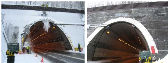
トンネル壁面の雪落とし作業
