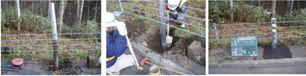
防護柵の補修
