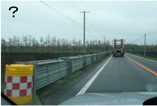
収納されないと景観向上は限定的、更に衝突事故の危険も。そのため景観阻害するクッションドラムもついてくる。
