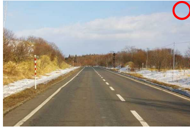
伸縮式視線誘導標により比較的良好な景観が確保されている。
