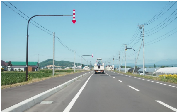
A: 開放的環境、空を背景に暗い色彩の例 ・ 明るい空にダークブラウンの標識柱が、より大きなコンクリート製電柱(明るいグレー)よりも際だって見える。
