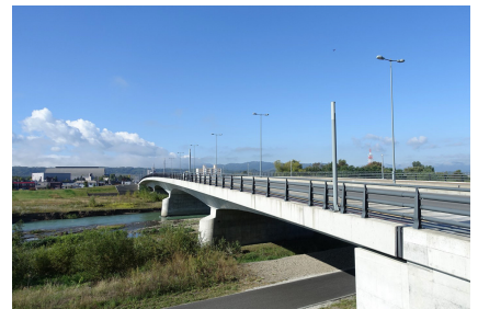
歩道用照明柱・標識柱：5BG5/1 高欄：5B3/1
