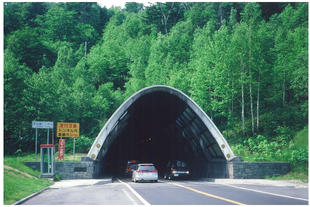
定山溪トンネルのPCルーバー
