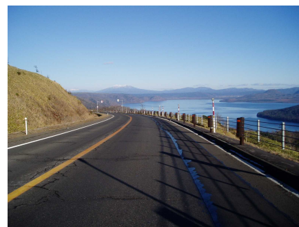
のり面へのラウンディング、眺望を阻害しない防護柵
