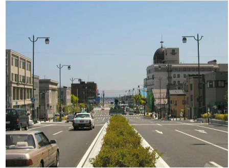
地域の歴史・文化に配慮した道路
