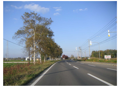
カーブの外側に視線を誘導する樹木が植栽されている
