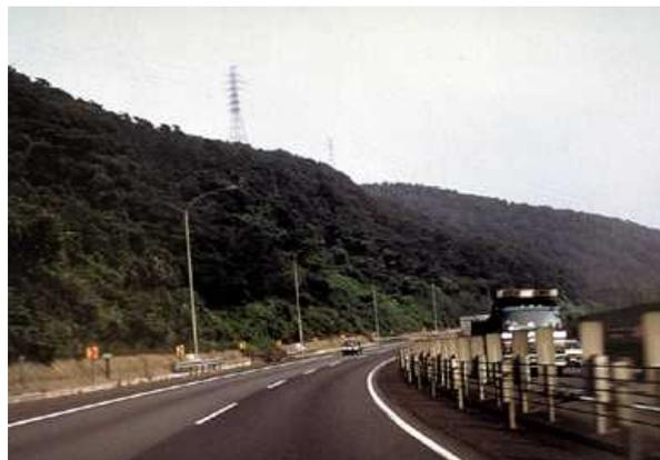
尾根や谷を周囲と連続させて造形した直後(左)とその30年後の姿(右)。連続する切土に対し、地山の起伏に合わせて尾根と谷とを明確に意識した丸み付けを行っている。現在では植生も回復し、そのような地形が元々あったかのような「新しい山」が形成されている。(東名高速道路・象鼻山)
