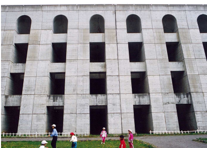
中景からは、柱と梁は立体に認識され、コンクリート表面に整然と割り付けられている目地がテクスチャーとして認識される。
