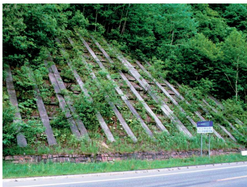
フレームの縦枠に比べて横枠の存在感を弱めるような造形的配慮を行った例
