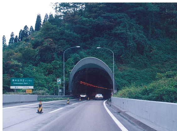
突出型坑門は構造物が露出する面積が少なく、進入抵抗感の低減に寄与する。
