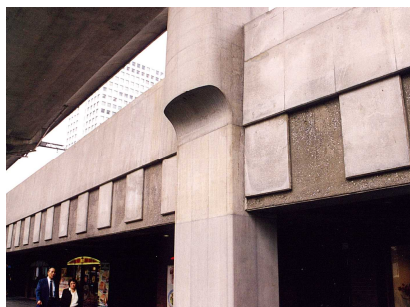
平滑面と洗い出し面とのコントラストを利用し、面の分割を図った鉄道高架橋の側面。
