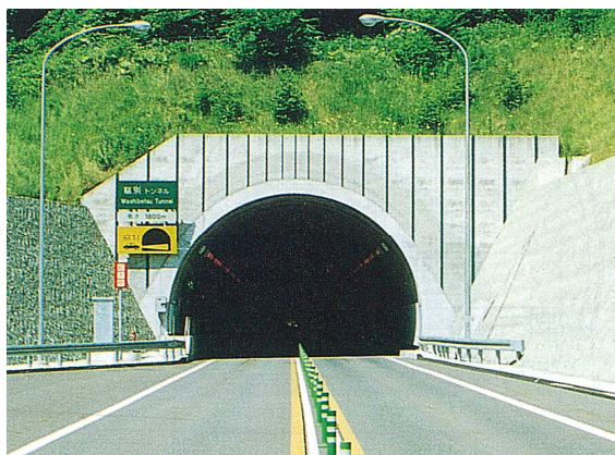
面壁型坑門はコンクリート面と坑内の明度差が極めて大きく、進入抵抗感を生み出しやすい。
