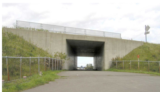
ハンチを省略し盛りこぼしとしているため、比較的シンプルな外観が得られている。
