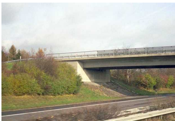
橋台付近に植栽を施すことで、走行車両から見た橋梁のおさまりを向上させている跨道橋。構造物が持つ硬質感がやわらいで見える。
