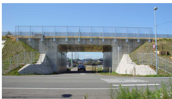
複雑なラインを描く盛土とそれに伴うブロック積み擁壁などの景観阻害要因が織り込まれている。
