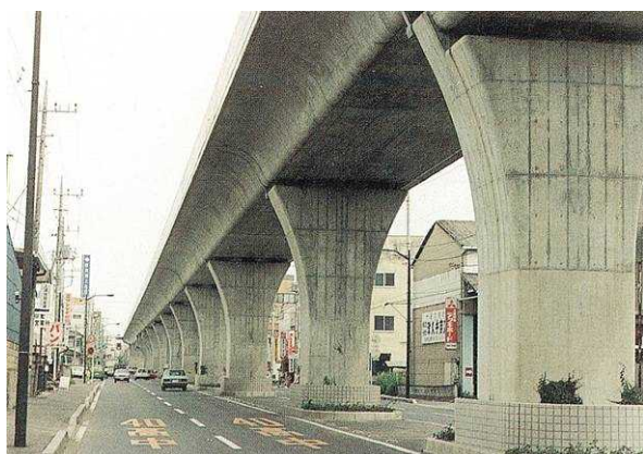
上部工との関連性が高い橋脚形状とすることで、構造物としてのまとまりを生み出している事例(出典:資料6)
