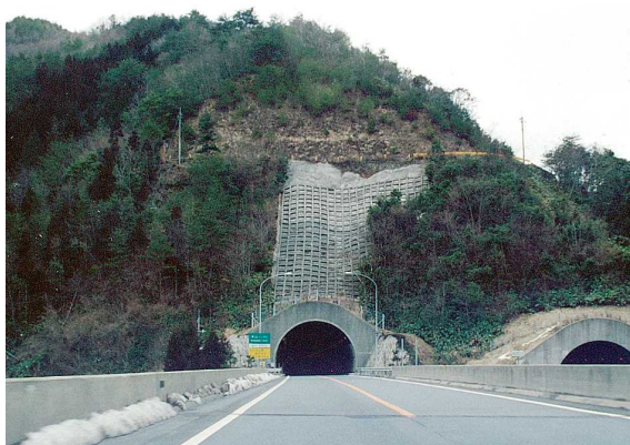
トンネル坑口上部の斜面をコンクリートのフレームで安定させている事例。道路利用者の視線にさらされるトンネル坑口周辺において、「山を傷めている」ように見える整備手法は人間の傲慢さの象徴となり、不愉快な印象を与える。
