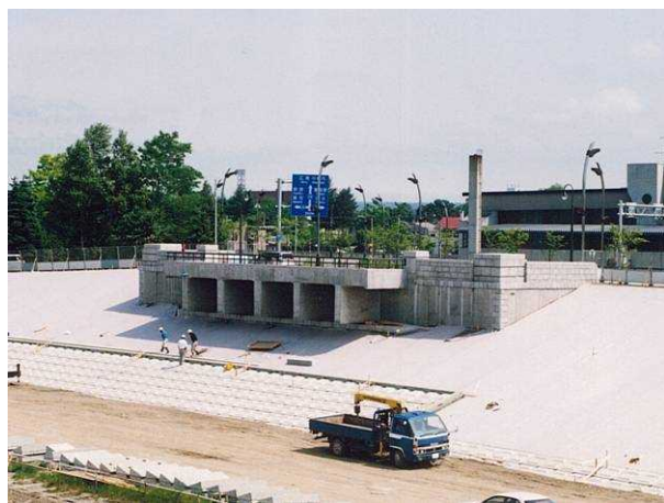
旧橋の橋台を移設し、名橋の存在を残しながら整備した視点場の事例。絶好の橋梁景観を得ることができるが、人工感がやや強い空間となっている。（十勝大橋・帯広市）
