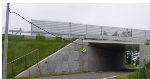
ケーブルがむき出しになっており、外部景観を阻害している。
