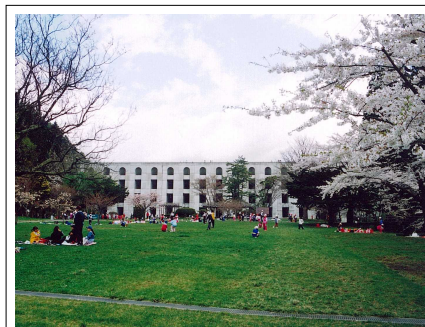
遠景からは、バットレス構造による柱と梁のコントラストが表面のテクスチャーとして認識され、独特の景観を生み出している。
