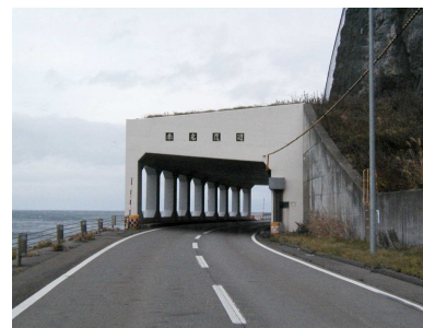
天端の勾配と道路に合わせた内空形状により、構造物自体がいびつで不安定な形となって見える。
