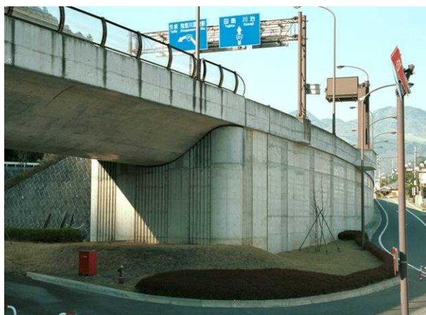
橋梁と擁壁のフェイスが連続して設けられている。壁面が縦方向に二分割されて見え、ボリューム感を抑制している。上下部がまとまった構造物として視認される。
