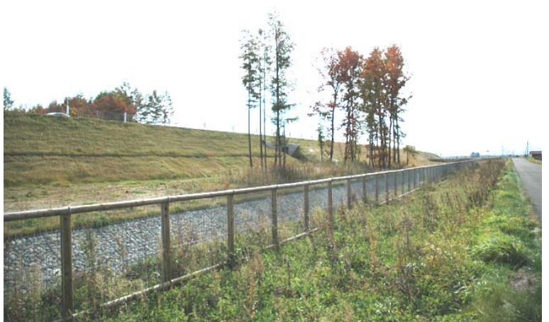
帯広広尾自動車道・帯広市
