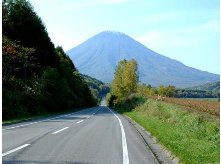
国道 276 号・喜茂別町
