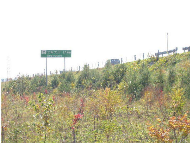
国道 5 号・七飯町
