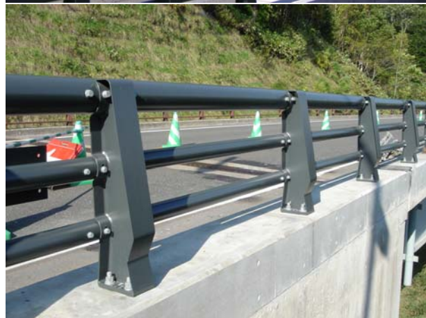
ガイドラインに基づき美笛グリーンに塗装された奥漁川橋 (写真・上) と、美笛グレーの冬笛橋 (写真・下)
