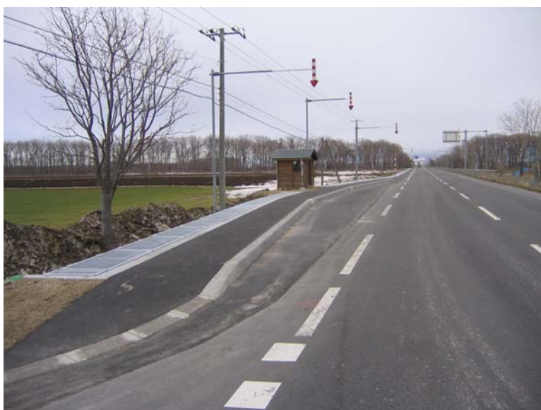
国道 244 号・斜里町美咲
