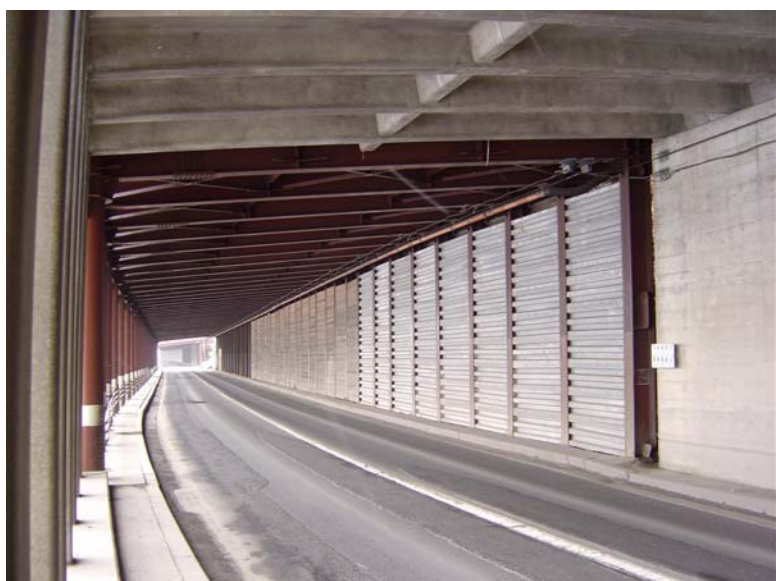
国道 229 号・古平町
