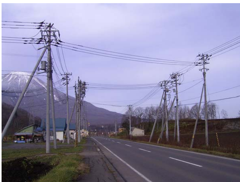
国道 276 号・喜茂別町
