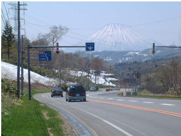
国道 230 号・喜茂別町
