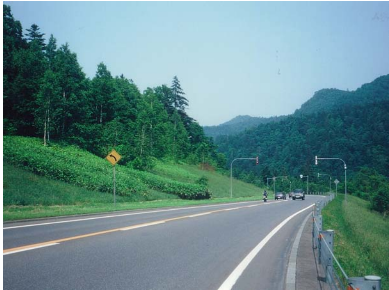
国道 230 号・札幌市
