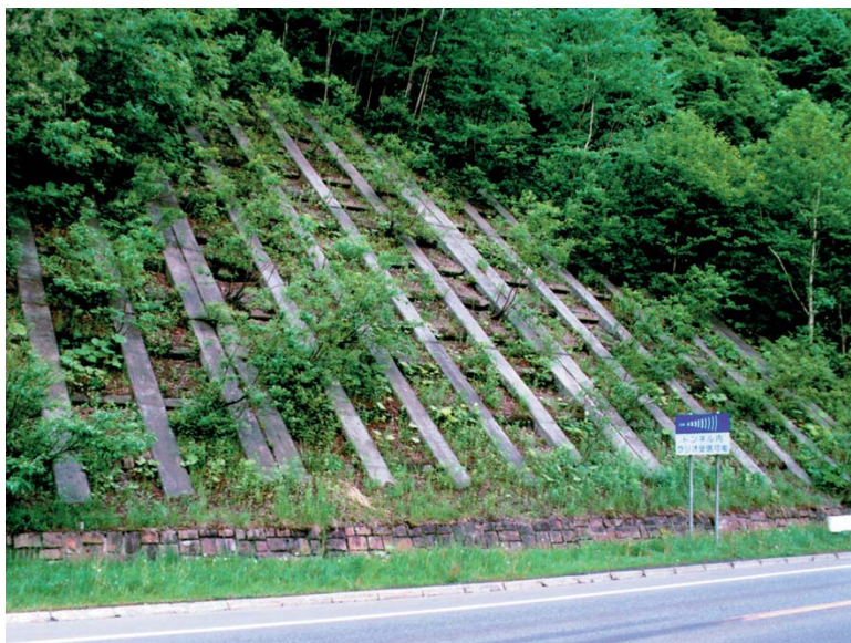
国道 230 号・札幌市
