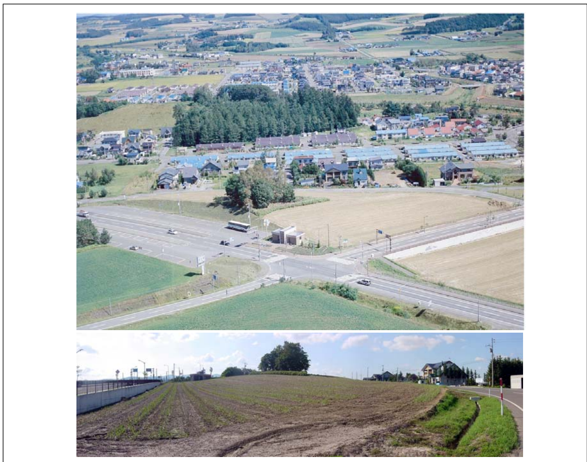
図 5.9.2 現地の状況（整備前）
