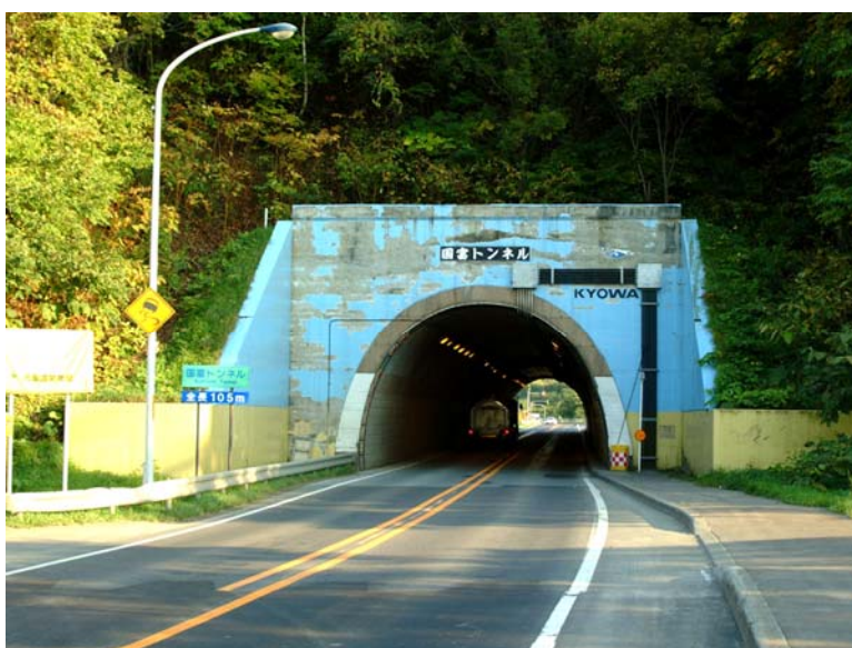
国道 276 号・共和町
