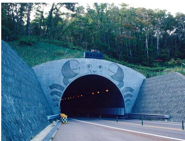
道央自動車道・室蘭市
