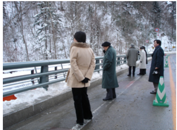
鋼管サンプル（写真・上）、モックアップ（写真・中）による現地検討を経て、試験施工による冬季景観の検証（写真・下）を行ない、確定した。
