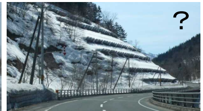
吹雪の発生しやすい区間を通過することで後に防雪柵が設置され、雪崩の発生しやすい勾配のり面を形成することで雪崩防止柵が設置される
