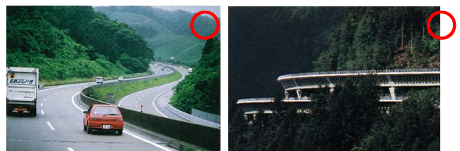
上下分離構造を採用した事例(北陸自動車道(左)・フランスA40(右)) 出典：写真左(日本のグッドロードガイド)、同右(A40パンフレットより)
