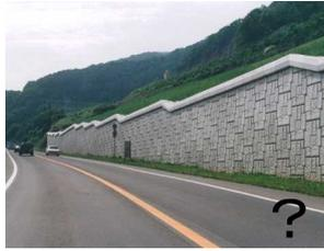
擁壁の天端の不連続な段差、笠コンクリートによる強調により、無秩序で不自然な印象を与えている（石積み風の化粧型枠で同じ模様が繰り返され、逆強い人工感）。
