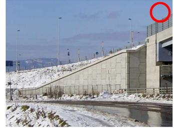
②表面の見え方を整える：フェイスアによる陰影により外観が引き締まって見え、巨大感を抑制している。表面に施された化粧型枠によるテクスチャーが表面輝度を低減し、秩序とリズムを生み出している。
