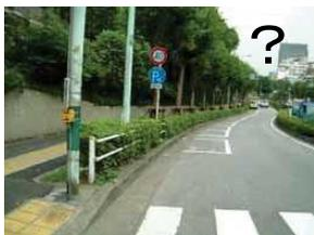
植樹帯と横断防止柵を併用しているが、植樹帯により歩行者の横断防止機能が確保されているため、横断防止柵は必ずしも必要ない (出典: 資料1)
