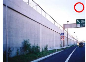
③存在感を緩和する：擁壁の位置をセットバックして前面に植栽スペースを設け、壁面を部分的に覆うと大きな効果が得られる。また、擁壁天端に植栽を施すことやツタ類による壁面の被覆などでも壁面の印象を和らげることができる。
