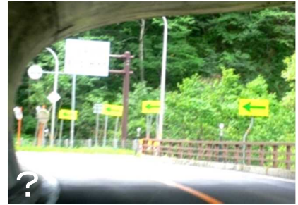
蛍光色を採用したシェブロン事例
