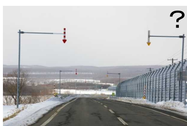
防雪柵設置区間に矢羽根が併用されている事例。 (矢羽根基礎部の位置から防雪柵設置に合わせて再設置か？)
