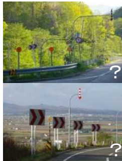
視線誘導標とシェブロンが同時に設置された事例
