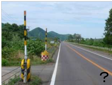
防護柵端末にクッションドラムが置かれて景観を損ねている事例
