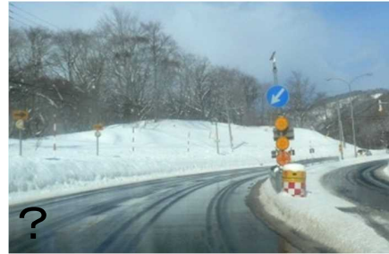
中央分離帯に標識・大型の反射板・クッションドラムが連鎖的に整備されている事例
