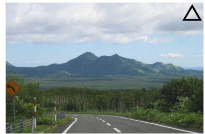
伸縮式視線誘導標で良好な景観が確保されている事例。収納するとさらに景観が良くなる。
