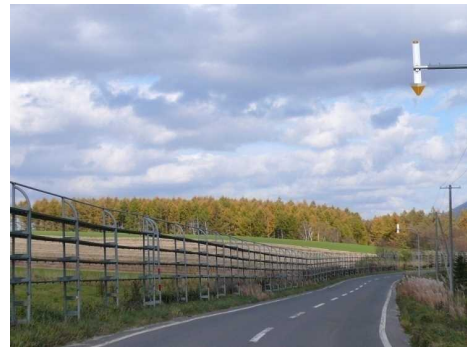
従来型は景観阻害が大きい一方、自動車の目線には景観が透けて見え、手前の畑の景観が視距可能である。
