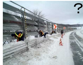
毎年のように発生する防雪柵の除雪 防護柵によって雪堤がある区間での視程障害
