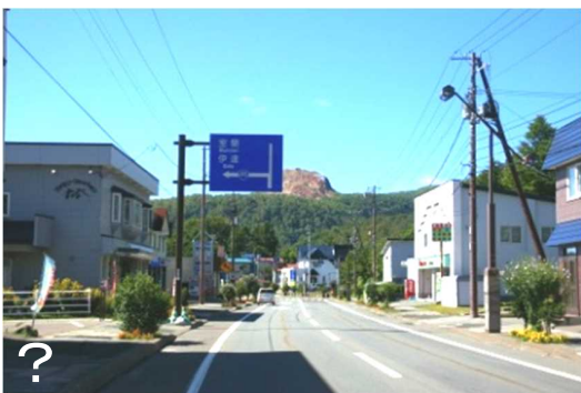
歩車道境界に設置された道路案内標識。衝突を防止するためクッションドラムなどが置かれ、さらに景観を悪くする場合もある。
