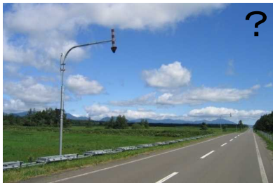
景観に配慮し折りたたみ式防雪柵を設置しているが、同時に矢羽根が設置され、チグハグな事例。
