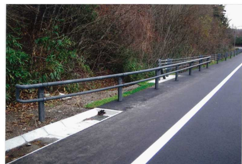
端末部にガードパイプを用いた事例
