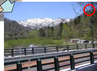
一定区間で色彩ガイドラインを作成し、前後の防護柵とも違和感のないグレー調で高欄の色彩を改善した事例(国道276号)
