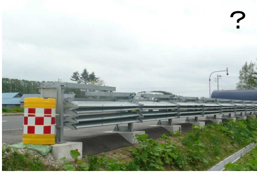
折りたたみ式では、道路の外部景観を大きく阻害。地域の田園景観に与える影響も小さくない。
