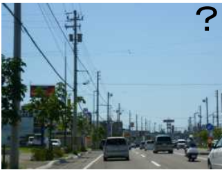
歩車道境界に電柱が設置され、閉塞感のある道路
