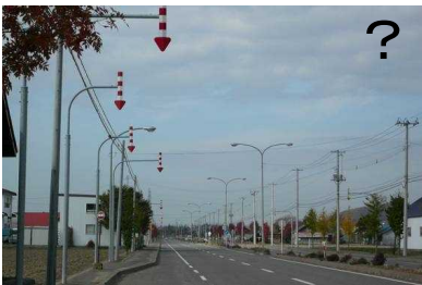
同様に、バスベイに矢羽根を設置した事例。市街部での連続照明区間に設置している。
