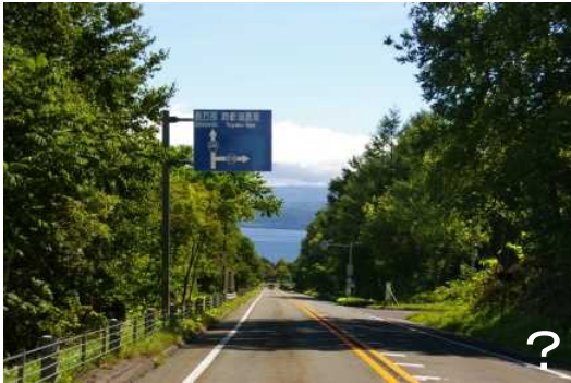
一般的な道路案内標識の設置状況
