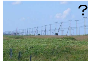
乱立する道路の柱類
