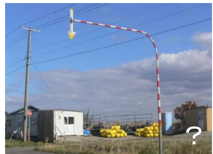
本来、矢羽根は緑石位置を確認するものだが、支柱を赤白にした事例。
