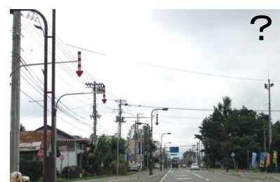
市街部で連続照明も設置されている区間での矢羽根設置の事例。
