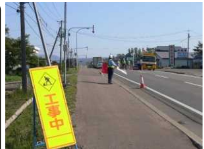
工事看板の事例。蛍光色は通常、ドライバーが道路構造上予測できない事態でこそ使用したい。
