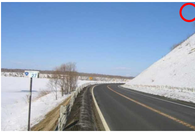
積雪の少ない地域において、防護柵で視線誘導を図っている事例。矢羽根等がなく良好な景観が確保されている。
