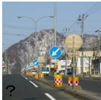
分離帯開口部毎にクッションドラムが設置されている事例。
