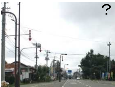
固定式視線誘導柱と道路照明
