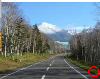
伸縮式視線誘導標により美しい道路景観が維持された事例
