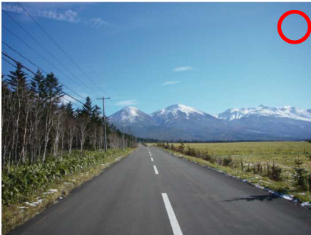
防護柵のないすっきりとした道路構造
