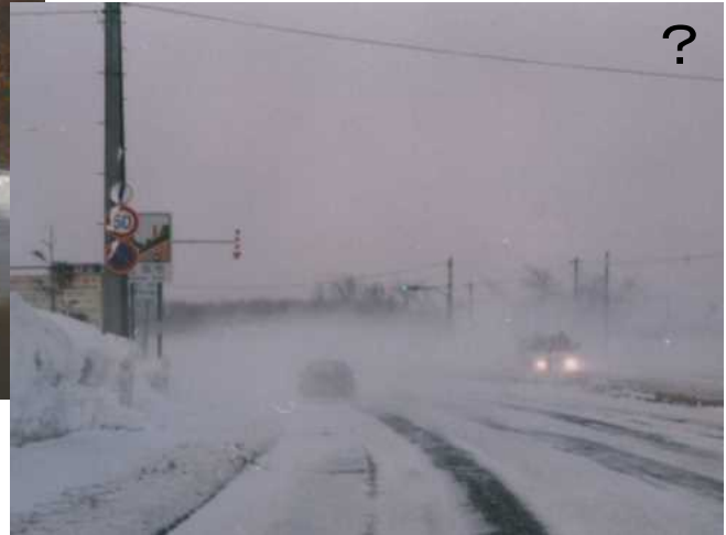
雪堤がある区間では、ドライバーの目線で視程障害が発生している事例
