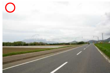
完全収納式防雪柵の採用により、クッションドラムの必要性がない道路構造の事例
