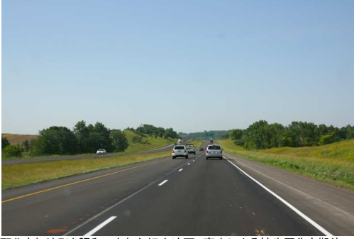
緩勾配化され地形と調和のとれた切土法面、高木による植生回復も期待できる
