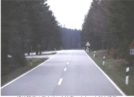
視線誘導は衝突時にも被害の少ない木製を採用。 (土木学会付属土木図書館 伊藤清忠景観デザイン・フォトライブラリー)
