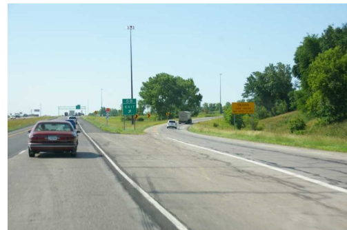
防護柵のない道路分岐
