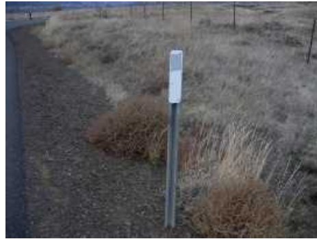
簡易な視線誘導標 (ドーコン・フォトライブラリー)
