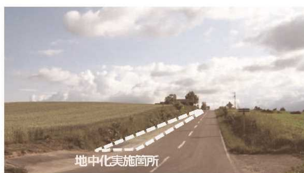
写真：自治体独自の費用負担により電線類を地中化
