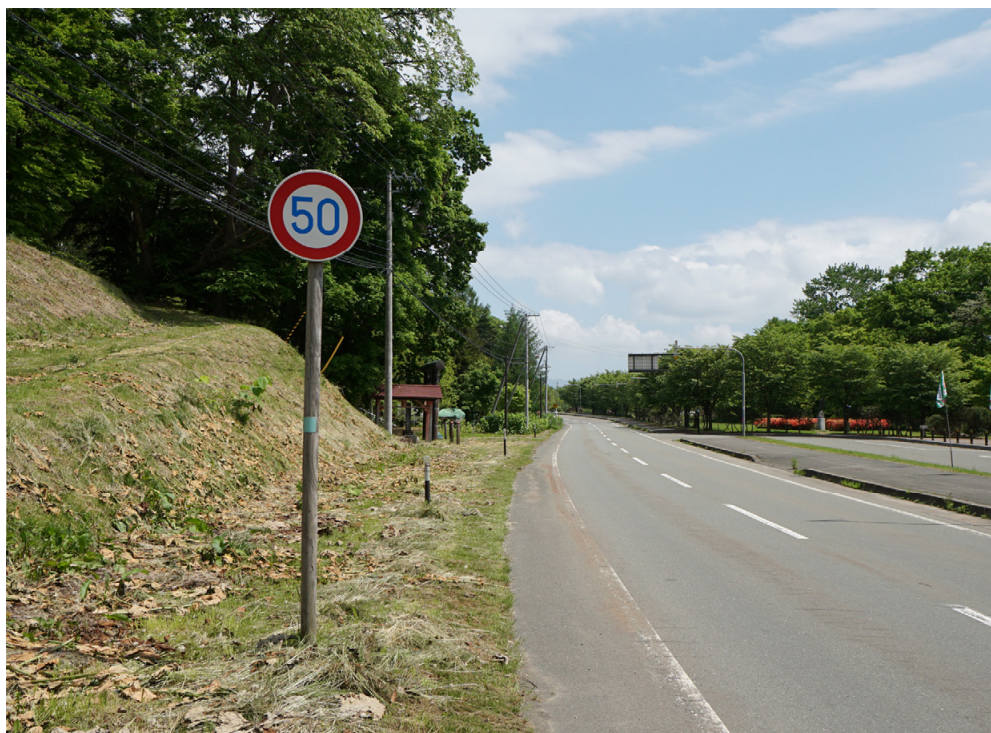
写真 4-2 木製の標識柱の例
