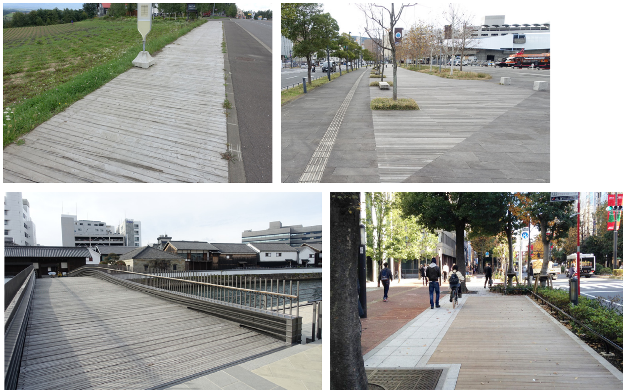
写真 5-7 路面材料として木材が用いられた例
