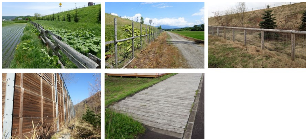
写真 4-4 調査対象とした木製の道路構造物 （上段：立入防止柵、 左下：防雪柵、 右下：歩道舗装）
