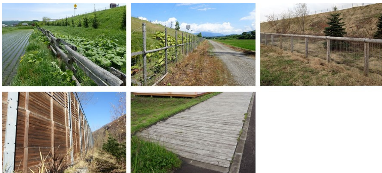
写真 A-3 調査対象とした木製の道路構造物
