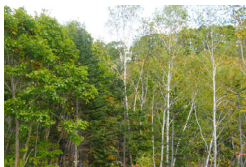
②切土箇所全景
