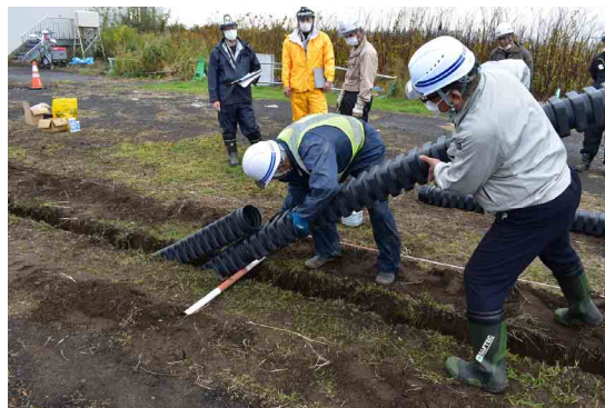
写真-3.28 角型FEP管の地上接続状況
