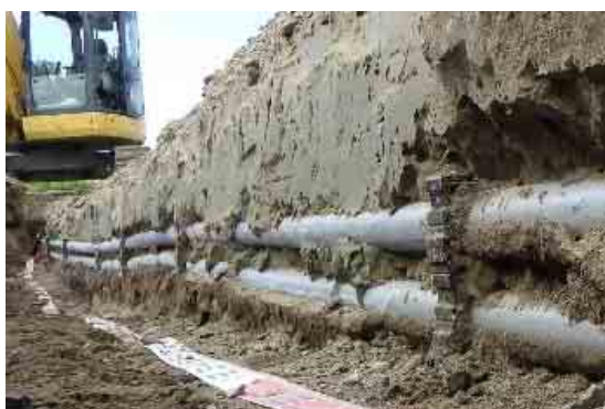
写真-3.44 流動化処理土充填性の確認（施工後1年） 左：RR-VE管、右：角型FEP管
