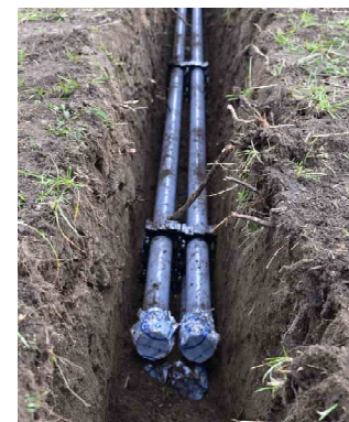
写真-3.31 狭隘断面に収まるRR-VE管
