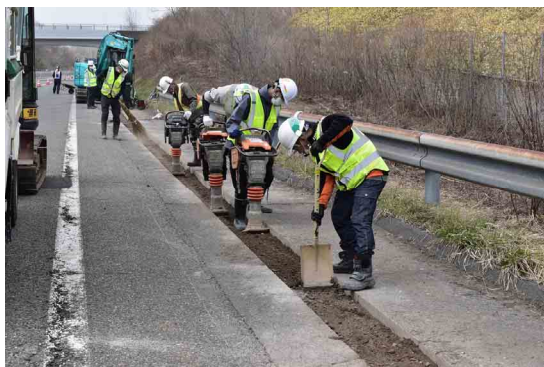
写真-3.46 タンパによる締固め状況 (写真は路盤の締固め状況)
