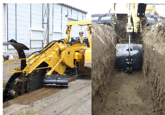
写真-3.3 ドラッグプレート及びトレンチクリーナー
