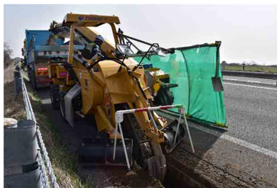
写真-3.24 掘削状況
