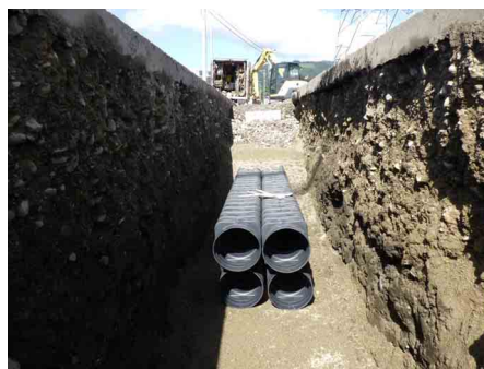
写真－1.3 国道電線共同溝におけるトレンチャー施工（北海道七飯町） （写真左：トレンチャー掘削状況、写真右：管路敷設完了状況）
