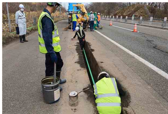
写真-3.27 掘削を追いかけて管路敷設が可能
