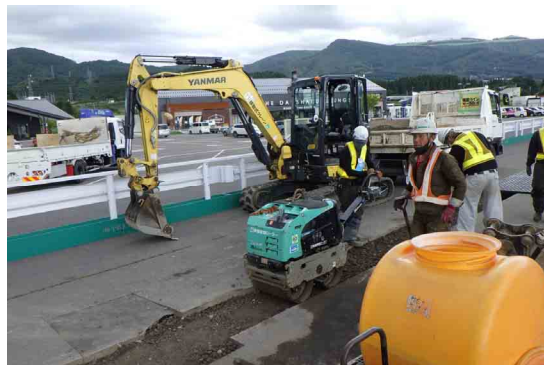
写真-3.47 路盤締固め（振動ローラ）
