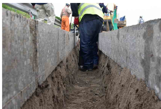
写真-3.37 床均しの状況 ※掘削床面は不陸がないため、スコップ等で均せば平坦な床付面を確保できる
