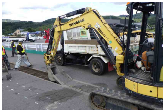
写真－3.14 舗装版の破碎・撤去状況
