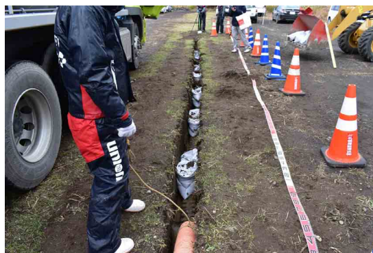
写真-3.43 土のうによる浮き上がり防止（角型FEP管）
