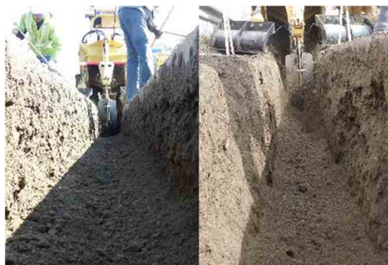
写真-3.25 掘削後（左：一次掘削、右：二次掘削）
