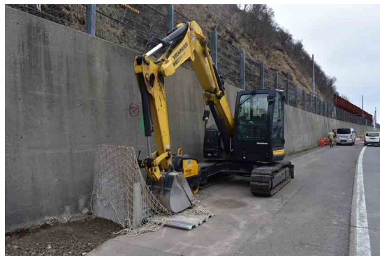
写真－3.50 端部を埋め戻さず翌日掘り返しを軽減
