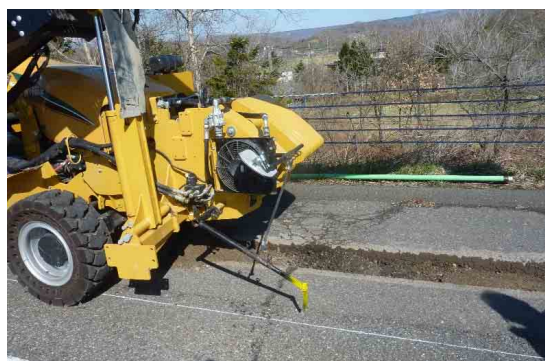
写真-3.16 掘削ルートラインの位置合わせ
