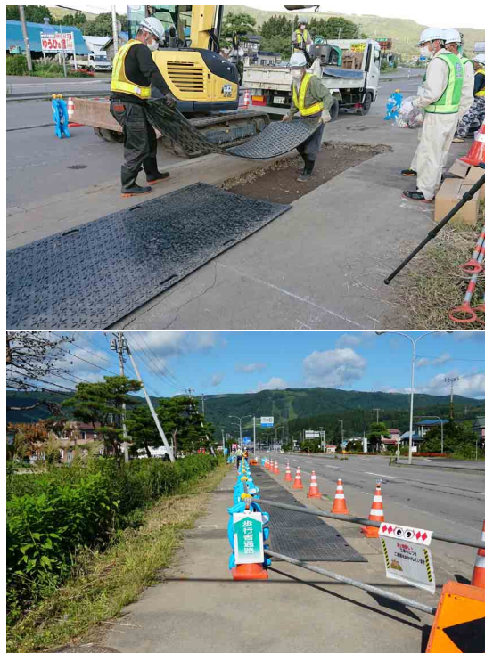
写真-3.48 路盤面の段差を合板で養生（上） 簡易な締め切りで開放（下）
