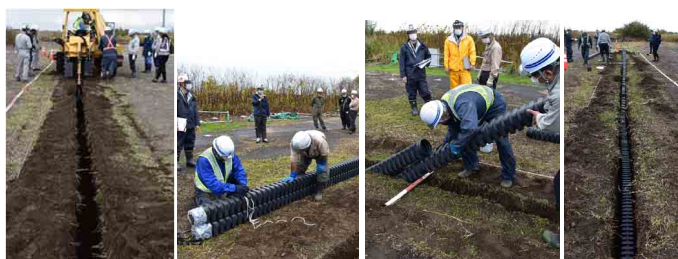
令和4年度試験施工状況（寒地土木研究所）※17～20
