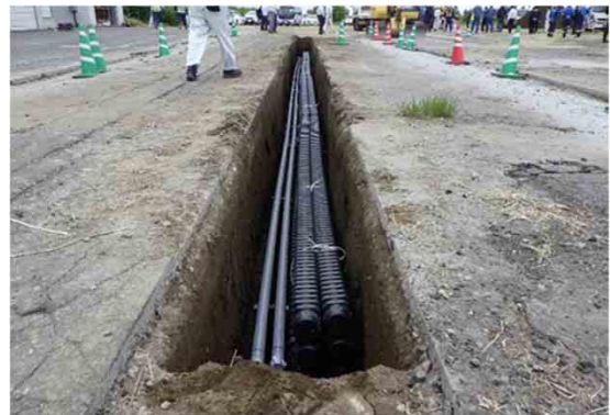
写真－3.34 最小限の掘削余幅で合計16条の管路敷設が可能
