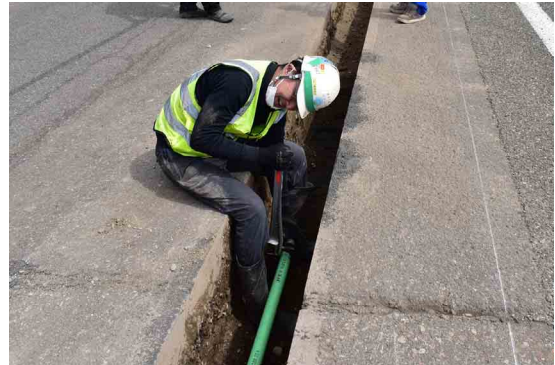
写真－3.32 小断面内での鋼管接続状況
