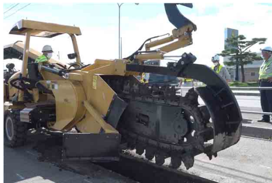
写真-3.15 掘削位置への移動（舗装の段差に注意）
