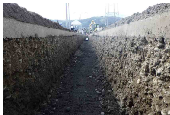
写真-3.23 幅61cm断面の掘削状況（路盤）
