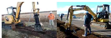
アタッチメント型振動コンパクタ による締固め
