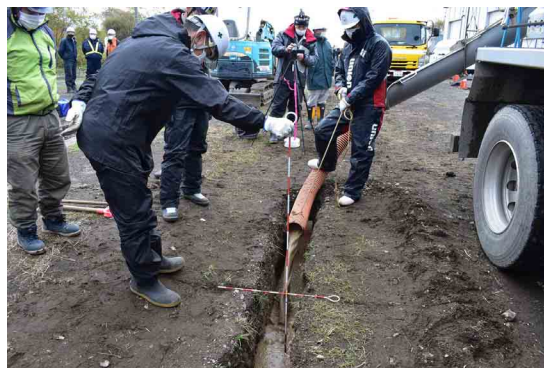
写真-3.42 流動化処理土打設状況
