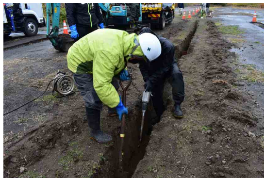
写真-3.38 砂充填状況（ハンドタンパ）
