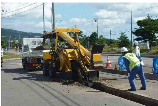
写真－1.3 国道電線共同溝におけるトレンチャー施工（北海道七飯町） （写真左：トレンチャー掘削状況、写真右：管路敷設完了状況）
