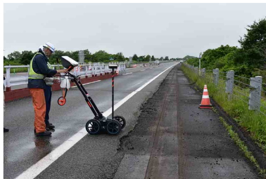
写真－3.13 舗装切断後の状況 (相応の時間を要するため、先行して施工可)
