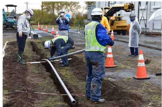
写真-3.30 RR-VE管の地上接続状況
