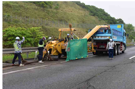
写真-3.19 ベルトコンベヤによる土砂積込
