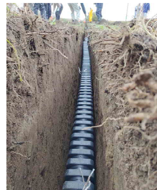
写真-3.29 狭隘断面に収まる角型FEP管
