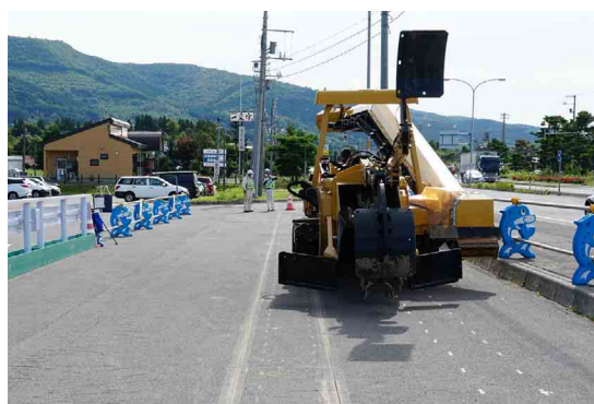
写真-3.10 掘削ライン及び埋設物の位置出し
