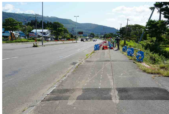
写真-3.8 施工基面の状態や勾配・段差を確認 低下縁石など進入路も確認
