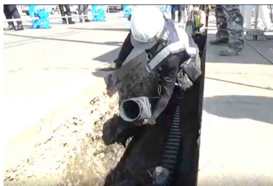
写真-3.26 角型FEP管の管路敷設作業状況
