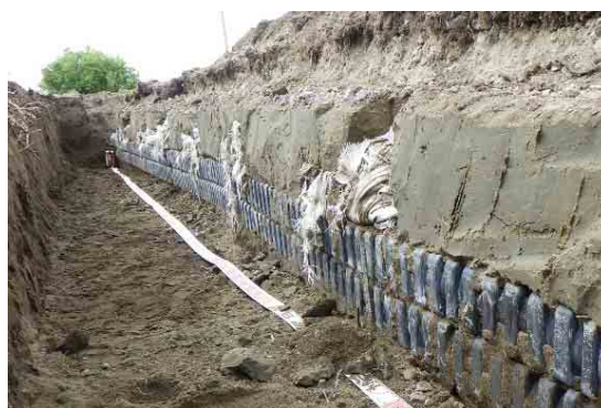
写真-3.44 流動化処理土充填性の確認（施工後1年） 左：RR-VE管、右：角型FEP管
