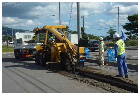
写真-3.18 掘削状況（誘導員による指示）
