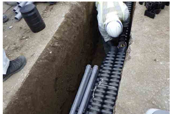
写真－3.33 w61×dp120内での管路敷設
