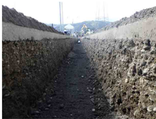
写真-3.7 トレンチャーによる掘削断面
