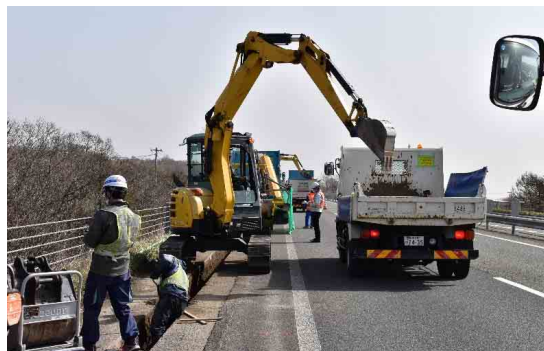
写真-3.45 小型バックホウによる投入状況 (写真は砂の投入状況)
