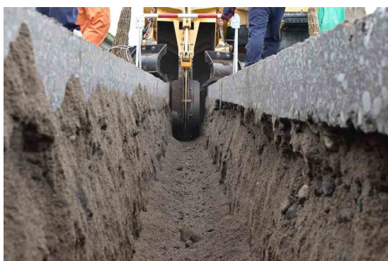
写真-3.36 掘削直後の床の状況 ※路面上に残った残土を断面内に戻している
