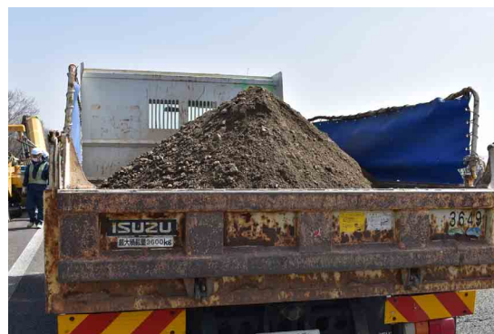
写真-3.41 トレンチャーによる掘削土
