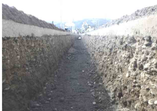
写真-3.35 掘削後の仕上がり状況
