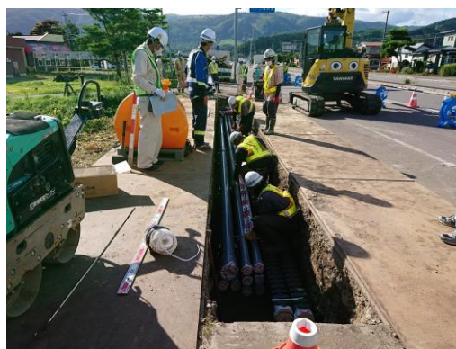
写真-2.2 深さ1m断面内での管路敷設状況 底が浅いため上下作業が可能になり施工効率が向上
