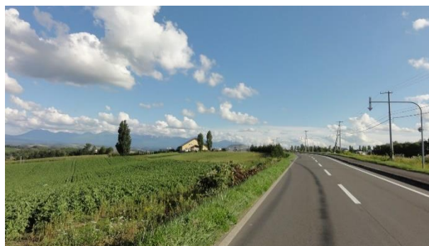
写真-1.2 実際の風景 (通信線を右側の電柱に移設し景観阻害を解消)
