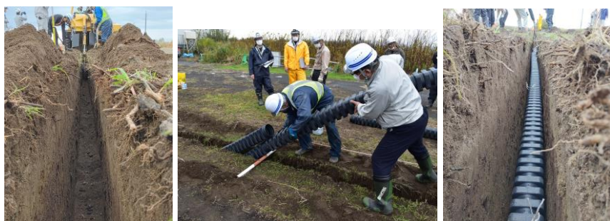
写真-2.9 掘削及び管路敷設状況 掘削断面は、壁が直立し確実に設計幅を確保している断面内に人は入れないが、地上で接続し落とし込んで敷設可能
