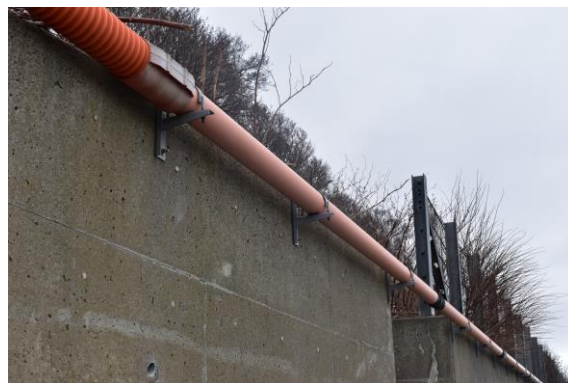
写真-2.43 固定金具で電力ケーブル保護管を固定
