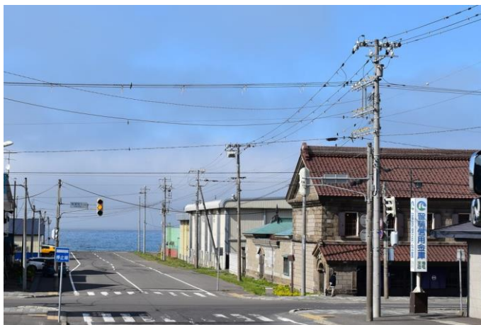
写真-1.24 鳥よけが設置された電線・電柱 (北海道増毛町)
