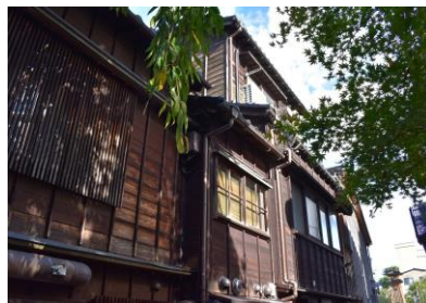
写真-1.3 軒下配線 （石川県金沢市主計町）
