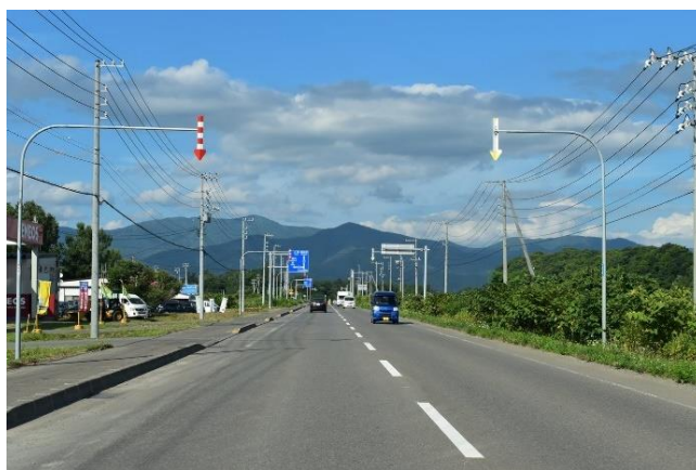
写真-1.26 占用位置の違いによる電線・電柱の見え方の違い (上：歩車道境界に設置、下：路外に設置)
