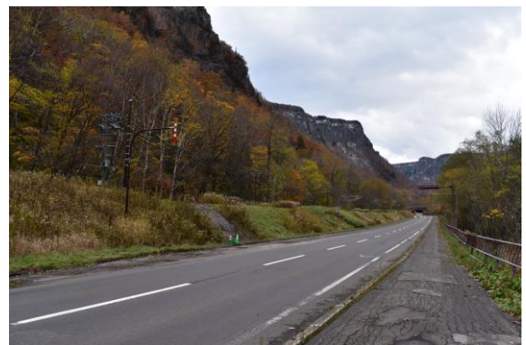
写真-3.28 災害時の電力復旧の強化のため 全国的に単独地中化が推進
