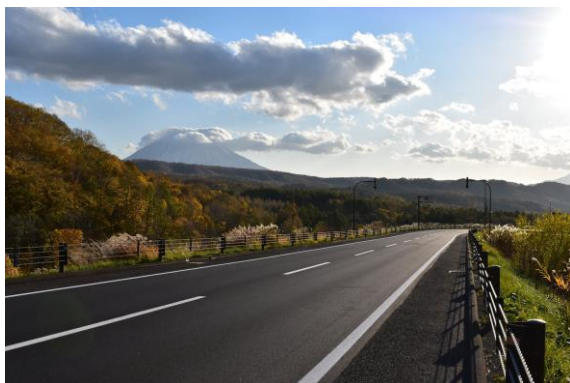
写真-3.13 国道393号メープル街道（北海道倶知安町） 北海道景観計画における景観重要道路に位置づけ 10) 道路新設時に電線電柱の占用が無く その後道路法第37条による占用制限区間になった 11)
