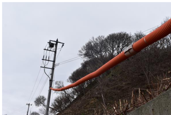
写真-2.42 「可とう電線保護管」をワイヤーで吊るして連系
