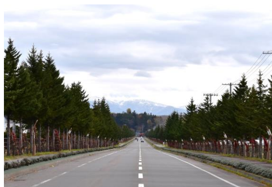
写真-3.17 旭川空港アクセス路（北海道東旭川町） 冬に訪れた方にも大雪山の山並みを魅力的に見てもらうために、針葉樹で電線・電柱を遮蔽
