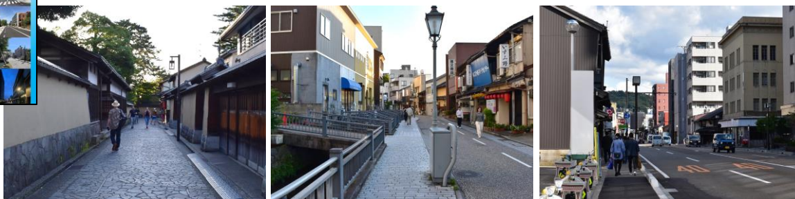
写真-3.1 無電柱化による街づくり（石川県金沢市） 無電柱化の3つの基本方針「景観・歴史まちづくり」「観光・商業まちづくり」「安全・安心まちづくり」
