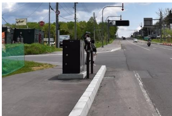
写真-2.14 歩道上に設置された事例
