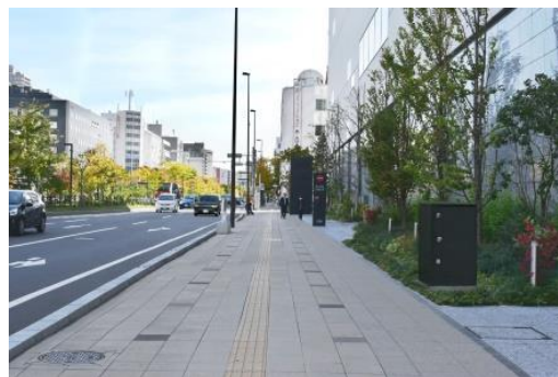
写真-2.17 地上機器の歩道外設置のイメージ 景観性と共に歩きやすさが向上
