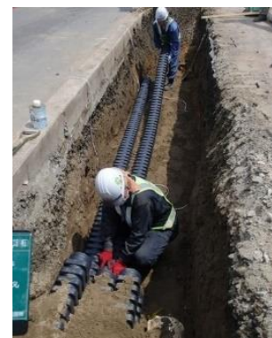
写真-2.5 角型FEP管管路敷設状況
