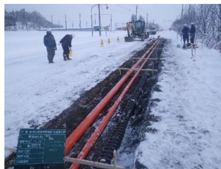
写真 試験管路（一般部区間：最小土被り13cm）
