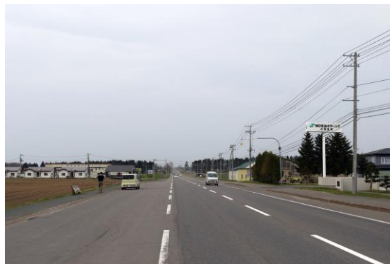
写真-2.25 ビューポイントパーキングの整備状況 (左) 整備前：来訪者が多い場所だったが、通信線が景観を阻害していたほか、交通安全上も課題があった (右) 整備後：駐車帯やベンチの整備にあわせて、眺望を確保するために眺望の反対側へ片寄せを実施
