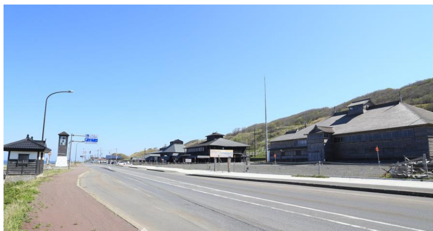
写真-2.28 「道の駅」おびら鯨番屋では、整備時に裏配線を行った
