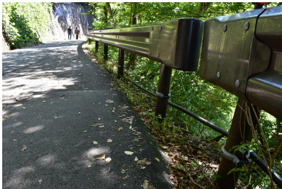
写真-2.39 街灯用の配電線を防護柵支柱に固定した管路で敷設
