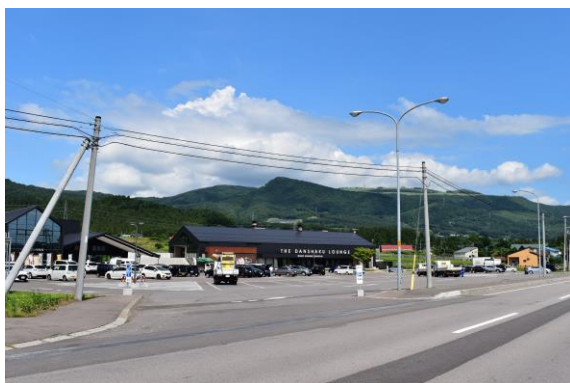
写真-3.6 道の駅なないろ・ななえ 「道の駅」整備を契機に、赤松街道の景観対策と国道施設として防災の観点から電線共同溝が事業化
