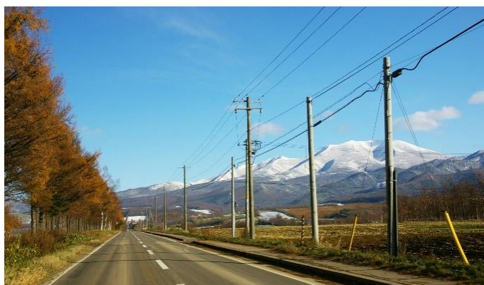
写真-1.16 既存電柱の中間に新たに建柱された通信柱
