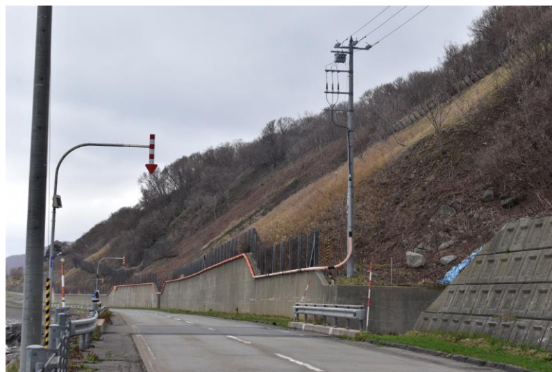
写真-2.41 国道擁壁に高圧電力線を収納する保護管を占用
