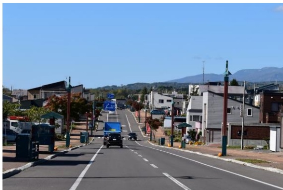
写真-3.18 綺羅街道（北海道二セコ町） 街並み景観整備事業と道路拡幅事業に合わせ地中化を実施 地域のまちづくりへの意欲と熱意により 多様な管理者・事業者との連携が構築され実現した 13)
