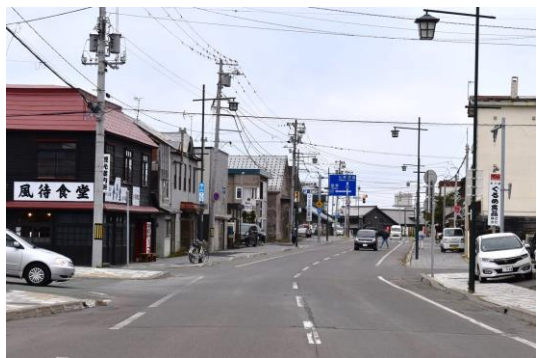
写真-1.23 北海道増毛町「ふるさと歴史通り」町並みの景観づくりと鳥の糞害の対策として無電柱化を計画
