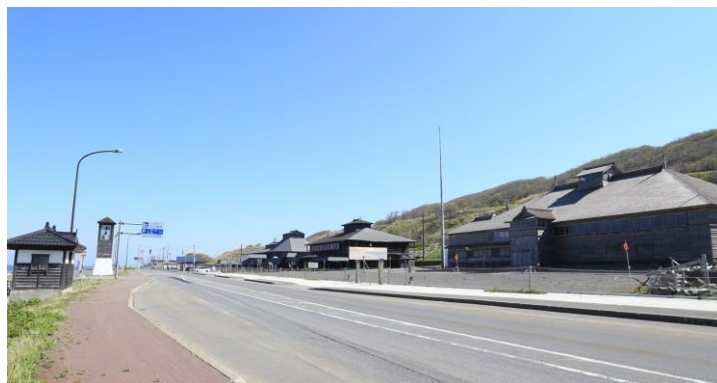
写真-3.5 「道の駅」おびら鯨番屋併設する歴史文化保存センターと共に都市再生整備事業の一環として無電柱化（裏配線）を同時整備
