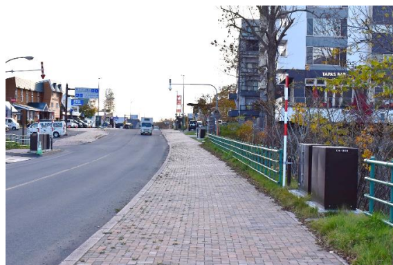
写真-2.15 歩道外に設置している事例
