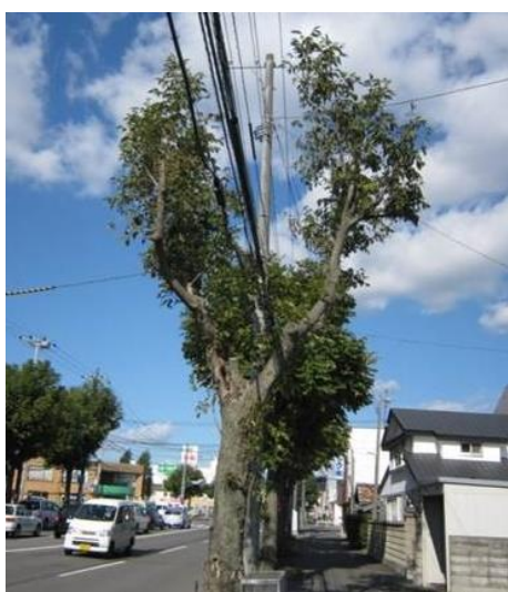
写真-1.18 通信線と街路樹が干渉し、街路樹を過剰に剪定している事例
