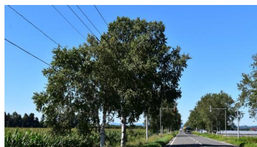
写真-2.33 樹木を貫く電線類には保護管を設置。
