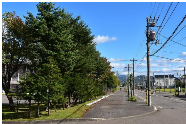
写真-2.7 街なかでも沿道が公園などで引き込み需要が無ければ共用FA管を削減できる場合がある
