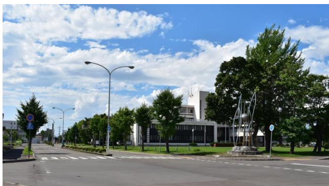
写真-3.11 美唄市役所 市役所敷地や公園の前面道路の電線・電柱の 占有制御により電柱の無い空間を実現
