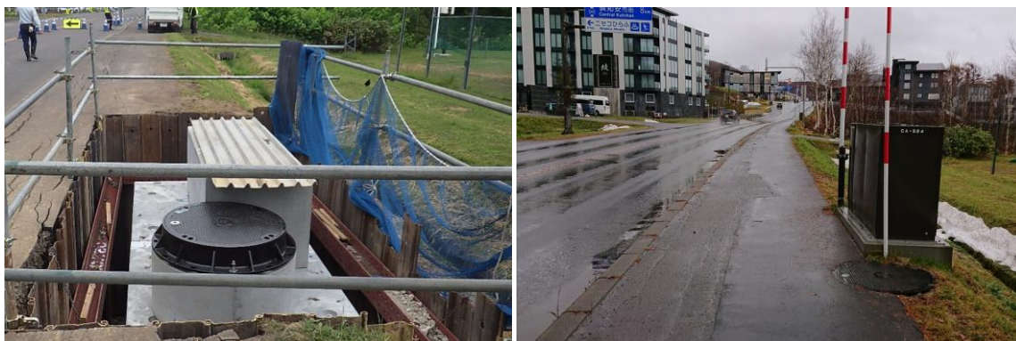
写真-2.11 特殊部の設置事例（上：施工時、下：完成後）（北海道倶知安町）
