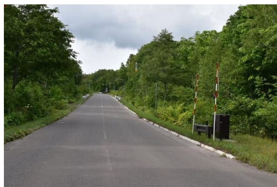
写真-2.13 森林区間であり共用FA管を不要とした区間 電力特殊部の設置間隔は250mに長延化（通信は中間に分岐樹を設置）
