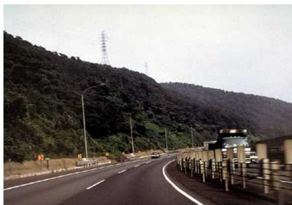
尾根や谷を周囲と連続させて造形した直後(左)とその30年後の姿(右)。連続する切土に対し、地山の起伏に合わせ尾根と谷とを明確に意識した丸み付けを行っている。現在では植生も回復し、そのような地形が元々あったかのような「新しい山」が形成されている。(東名高速道路・象鼻山)
