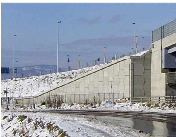
不連続な段差が生じやすい補強土壁の天端を直線で構成することで、全体形を整えている。さらに天端にフェイシアを設けるとともに、場所打ち部分の表面にはパネルに合わせたスリットを設けることで、不自然さを解消している。
