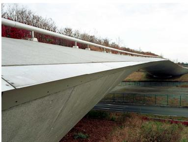
ステンレスの水切り板を設けることで、シャープなラインを形成しながら、コンクリート表面の汚れを防いでいる。
