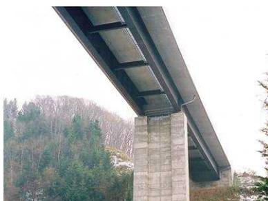
少数主桁橋は桁高が高くなる反面、桁下の見え掛りがシンプルになる
