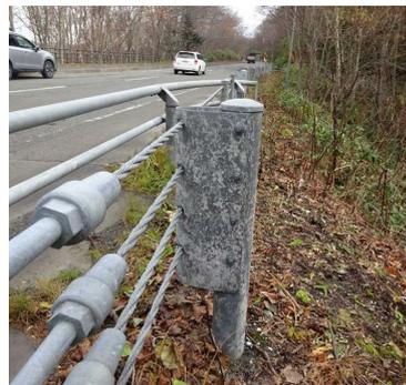
不均一な白錆が生じたリン酸亜鉛処理仕上げによるガードケーブルの支柱
