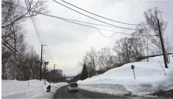
道路上を架空横断する通信線（荷重を支える結束ワイヤーが断線し部分的に弛んでいる）
