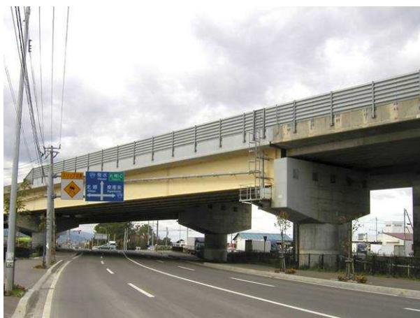
交通量が多い道路と交差する目立つ高架橋であるが、高い桁高や大きな張り出しのある橋脚、むき出しになっている排水管や検査路などによって極めて大きな圧迫感や煩雑感が生じている。（国道12号・札幌市）
