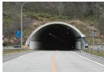
良好な坑口であっても、最終段階で設置される電力ケーブルなどで景観の質は低下する。
