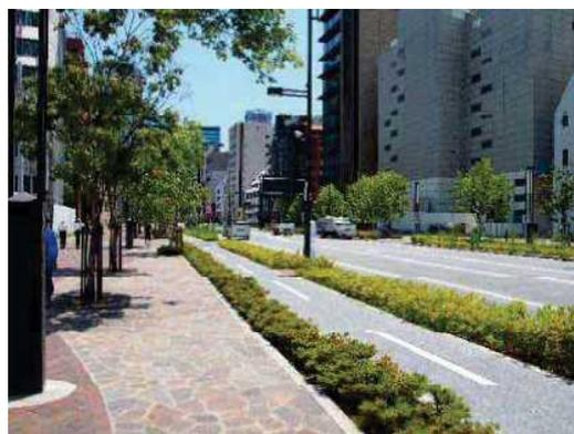
歩道内への自転車道の設置において、視覚的な変化とともに、自転車の走行性にも配慮された舗装材が選定された例（出典：資料 7）
