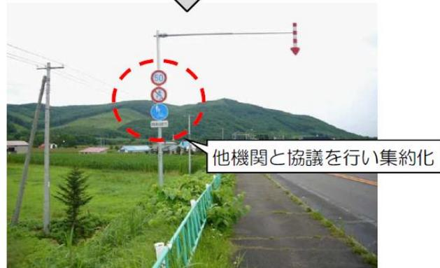
道路標識集約化の事例（出典：平成 29 年度 第 1 回 北海道道路メンテナンス会議（平成 29 年 7 月 14 日）資料 3「老朽化対策の取り組み事例」）
