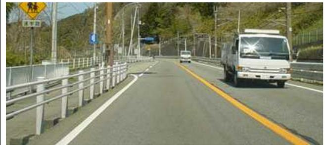
同一区間でガードパイプ・ガードレールが混在（車道）、縦柵・横柵が混在（歩道）している例
