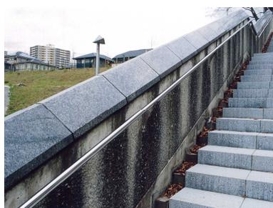
内側への傾斜を持つ笠石の目地が導水溝となって面壁に縞状の汚れを発生させ、不衛生な印象を与えている。
