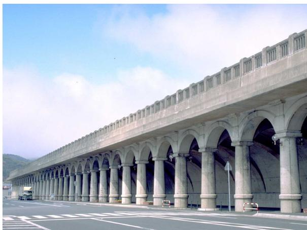
地域のシンボルともなっている防波堤の事例。コンクリートの造形における特長は可塑性にあり、自由に形態を生み出すことができる。造形で魅力を持たせる場合には、平滑面がふさわしいことが多い。
