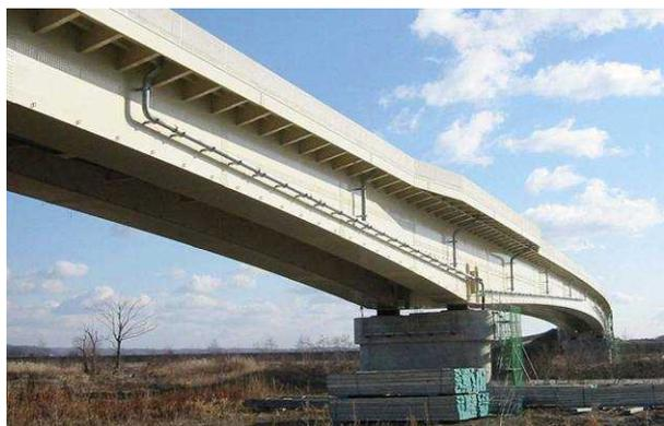
力学的合理性に基づいた美しいフォームを持つ橋梁であっても、設計の最終段階において排水機能と維持管理の観点のみで排水管を桁側に設置すると、橋梁景観は著しく低下する。
