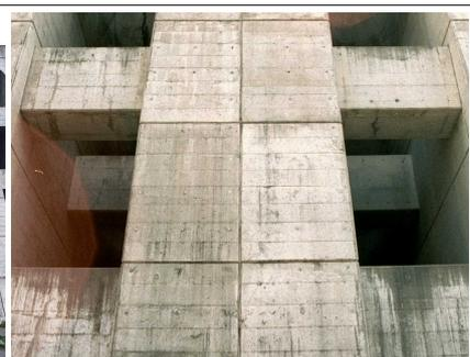
近景からは、横長の型枠やセパレーターの跡およびコンクリートの平滑面そのものがテクスチャーとして認識される。
