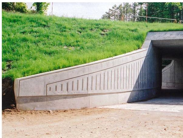
構造物全体の造形に合わせて、洗い出し仕上げをスリット状に設けることで表情を生み出している函渠。天端に勾配を持たせるとともに水切りのためのスリットを設けて汚れに配慮している。
