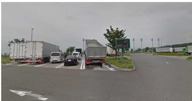
高速道路のサービスエリアにおいて、大型車等の駐車スペースに耐久性が高いコンクリート系舗装を使用し、走行路にアスファルト舗装を使用している。(出典：Google ストリートビュー)
