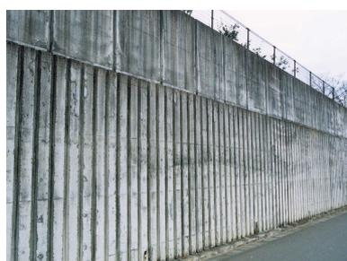
施工の質の低さと汚れにより、みずばらしい姿になっている擁壁。このような汚れは天端に勾配を設けるだけで回避できる。
