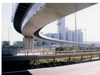
斜めウェブの箱桁は桁の底面が狭く見え、軽快感が得られる
