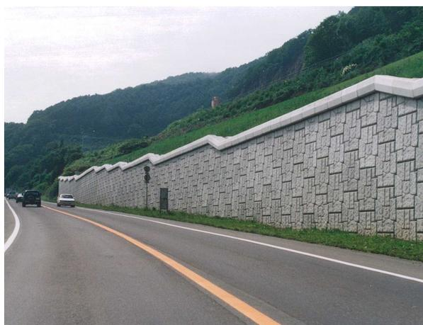
擁壁の天端に不連続な段差が生じており、さらに笠コンクリートによって強調されていることから、無秩序で不自然な印象を与えている。また、石積み風の化粧型枠による同じ模様が繰り返され、本物の石積みとはほど遠く、逆に強い人工感が生まれている。
