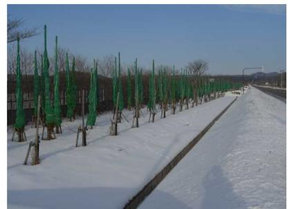
用地界に防雪柵を整備し、前面に植栽による遮蔽を施すことにより良好な道路景観が実現している事例。（道道52号・弟子屈町）
