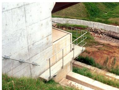
雨水がたまりやすい橋台沓座面に導水スリットを設けるだけで表面の汚れを防ぐことができる。
