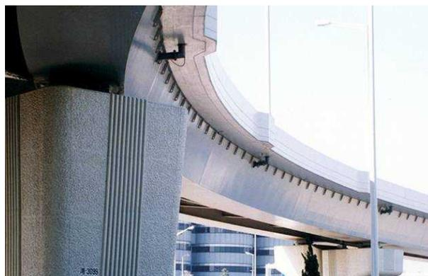
排水管を桁内へ引き込むことにより橋梁の側面景観をすっきりとさせている事例。積雪寒冷地においては管が破損する可能性があるため、注意を要する。今後の技術開発にも期待したいところである。
