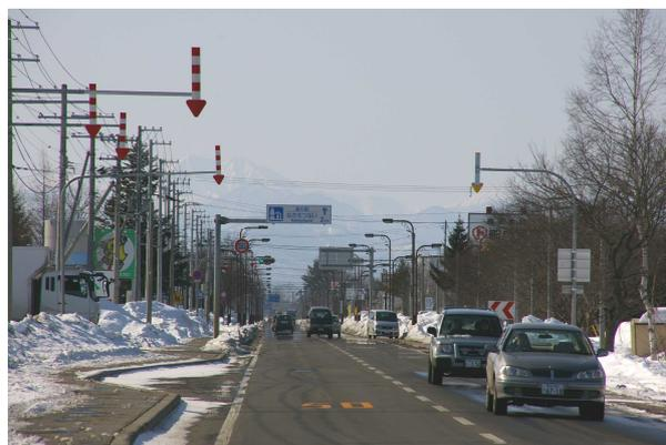
市街地で照明柱の設置された区間に、バスペイを示すために設置された固定式視線誘導柱は、機能的に不要であると言えるため、このような設置は基本的にしないことが望ましい。
