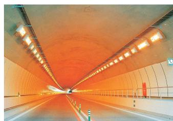
内装板の設置と照明の工夫によって、坑内の快適性は格段に向上する(出典:資料-8)
