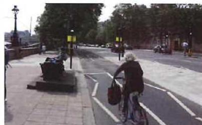
【サイクルスーパーハイウェイ・イギリス ロンドン】 ロンドンでは、自転車利用率の増加、公共交通の供給不足を見越して、市郊外部から中心部にアクセスする自転車道の整備に着手し、原則として、車道と物理的に分離する方式を採用している。（出典：資料6）
