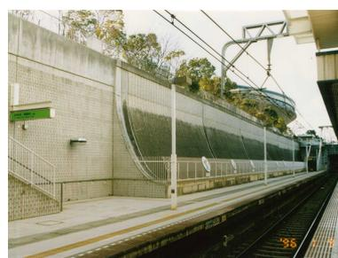
フェイスアが水切りとなり、鉛直面は汚れていないが、雨水が直接当たる傾斜面は汚れているため、違和感が生じている。
