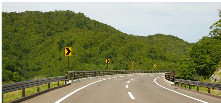
全体が視認できないカーブにおいて、同一の色彩・形状の線形誘導標示板が適切な間隔で設置されている。
