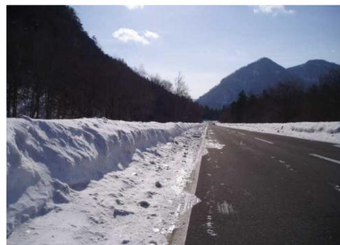
防護柵設置により雪堤が高く発生している区間
