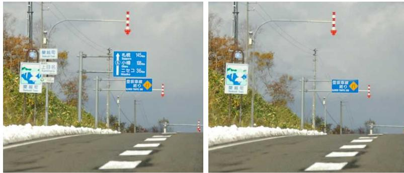
寒地土木研究所の研究\*における比較事例、左（写真）は情報量が多く複雑であるが、この地点に設置する必要がない確認案内等を移設することで、右（CG）のように情報量が少なくなり、景観面でも煩雑感が低減する。
