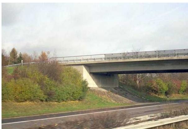
橋台付近に植栽を施すことで、走行車両から見た橋梁のおさまりを向上させている跨道橋。構造物が持つ硬質感がやわらいで見える。
