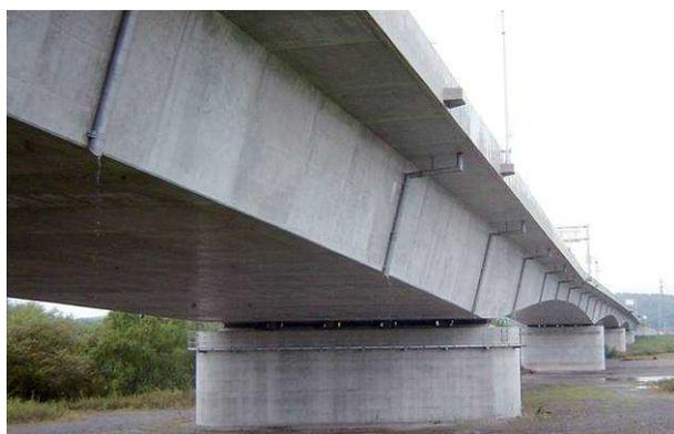
排水管を桁下端から 20cm の突出を設けるために、屈曲部を複数つくりながら延長させている事例。このように床版の張り出しが大きい場合には、短い管で終わらせることも検討すべきである。
