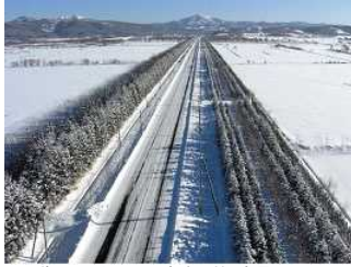
・国道40号 中川町国府防雪林 全景
