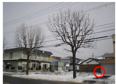
・電線巻込型(函館)
