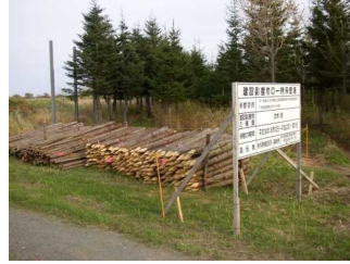
・雪圧防止杭-防雪林間伐材の再利用(R238 浜頓別)
