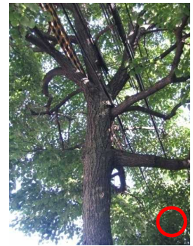
電線に鞘管を設置している例
