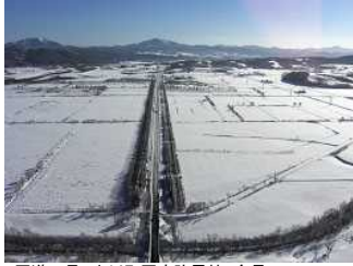
・国道40号 中川町国府防雪林 全景
