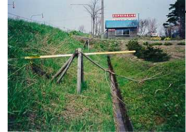
・支柱によって幹折した事例
