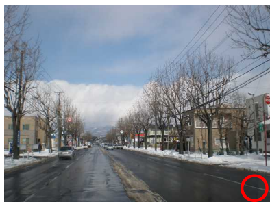
・電線巻込型(函館)
