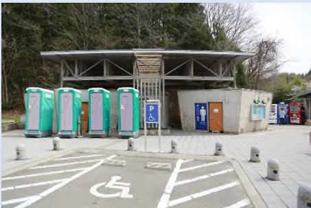
▲令和6年能登半島地震でトイレが使用できなくなったため設置された仮設トイレ[道の駅桜峠(石川県)]
