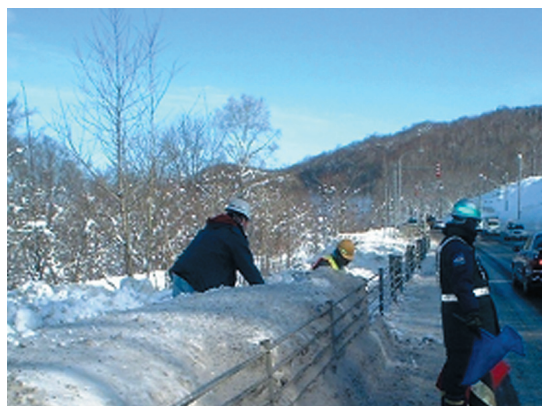
▲人力による防護柵背面の除雪作業でコスト増大
