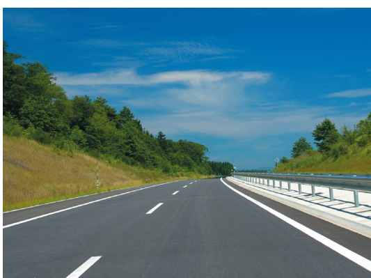
▲緩勾配法面で早期植生回復を期待
