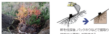
▲樹木導入手法 伐株移植 (伐株を掘り起こし、仮植または造成された植栽基盤に移植する)
