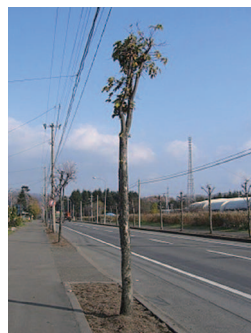
▲架空線との競合のため切り詰められたと考えられる街路樹。実際は架空線を取り込んだ育成が可能です。
