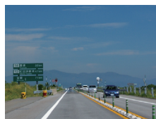
▲高速道路での設置例(日本)
