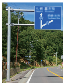
▲一般的な片持式(F型柱)案内標識(敷地に余裕がない場合に有効)
