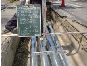
▲国内県道における浅層埋設事例。施工時間の縮減につながるほか、大型重機による作業スペースが確保できない狭隘道路においても有効となる。
