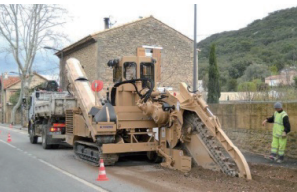
▲専用の掘削機械による郊外部道路の施工事例(イタリア) ※TESMECH社ホームページより
