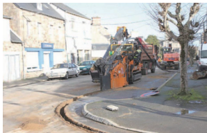
▲市街地における掘削・布設の一括施工事例(英国) ※Apwell社ホームページより ▲市街地における掘削・布設の一括施工事例(英国) ※Apwell社ホームページより ▲市街地における掘削・布設の一括施工事例(英国) ※Apwell社ホームページより ▲市街地における掘削・布設の一括施工事例(英国) ※Apwell社ホームページより
