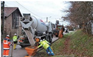
▲掘削・布設・埋め戻しの一括施工事例(英国) ※Apwell社ホームページより
