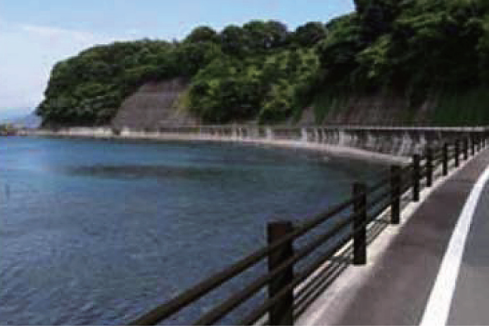
▲景観に配慮した防護柵(静岡県)
