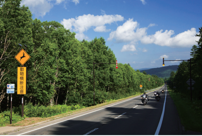
▲景観配慮を目的に、こげ茶色に塗装された視線誘導施設と標識の支柱
