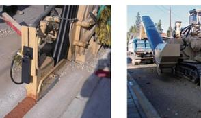
楕円状のチェーンに掘削用の刃が付いたもの。比較的深い掘削深さの施工に適している。
