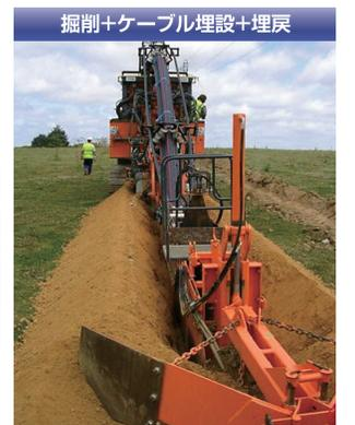
掘削+ケーブル埋設+埋戻
