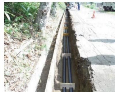
千歳市水道局では、支笏湖温泉地区の簡易水道用電力ケーブル更新工事において、浅層埋設を行いました。土被りは、従来の市の基準の120cmから60cmまで浅くし、低コスト化を実現しました。
