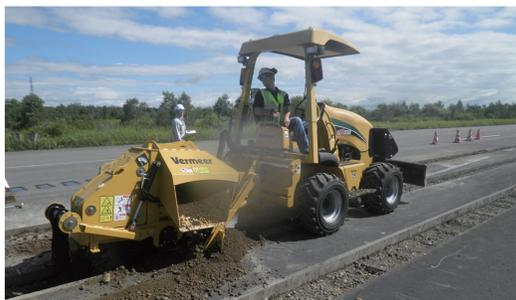
欧米諸国の農村自然域では、専用の掘削機械を用いて低コストで効率的に無電柱化を進めています。これらの施工方法を導入することで施工性が飛躍的に向上します。
