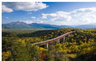
▲雄大な自然と橋梁の対比が美しい(国道273号三国峠)
