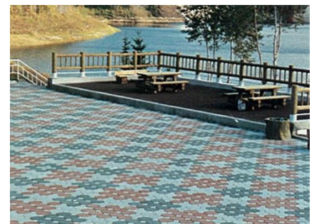
写真-1 周囲の環境に調和しておらず景観配慮が適切でない舗装の例
