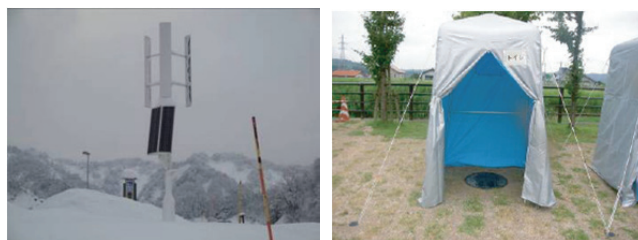
写真-4 災害時に有効と考えられる太陽光と風力発電の照明施設やマンホール活用非常用トイレ
