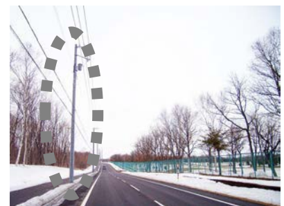
写真-3 郊外部において歩車道境界付近に電柱が設置された事例
