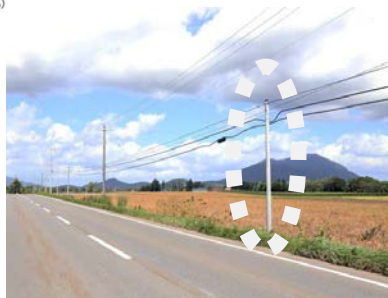
写真-2 通信線の増加に伴い通信用の電柱が増設された事例
