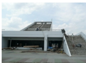
写真-8 津波の際に避難者の命を守った「道の駅」の避難階段
