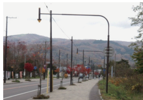
茶系塗装の電柱は積雪期には目立つ 民地等の活用による対策も可能では？
