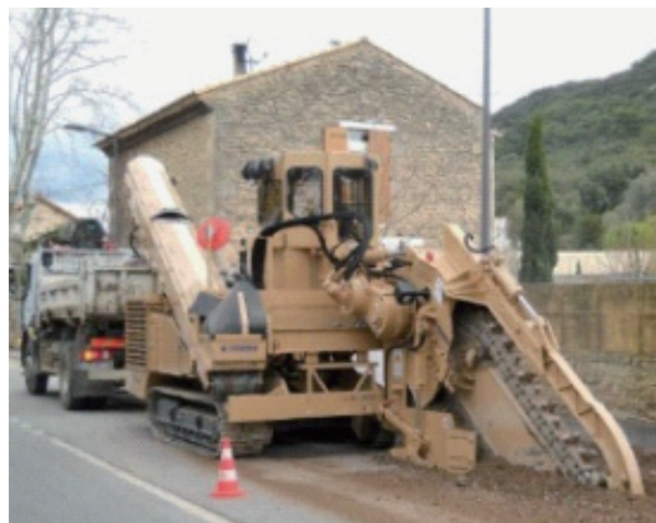
掘削機械による郊外部道路の施工(イタリア)
