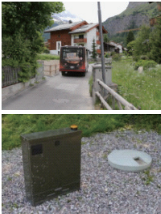
狭隘道路や郊外部に適した地上機器の開発・設置手法の検討
