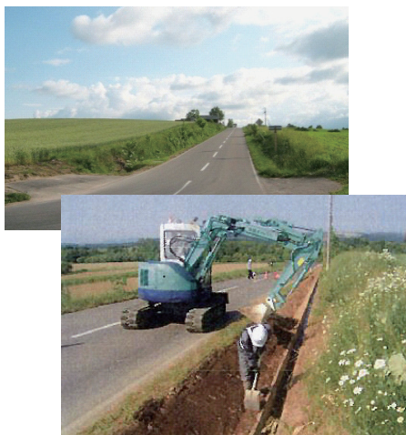
国内の郊外部における無電柱化施工事例(日本)
