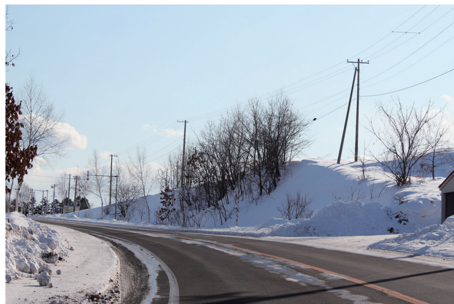
以前は厳格に基準が運用され、法面奥の敷地外や用地境界に占用されている事例
