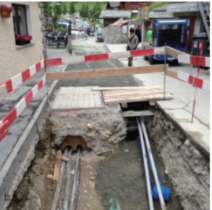
寒冷地における直接埋設および引込み部の施工例(スイス)
