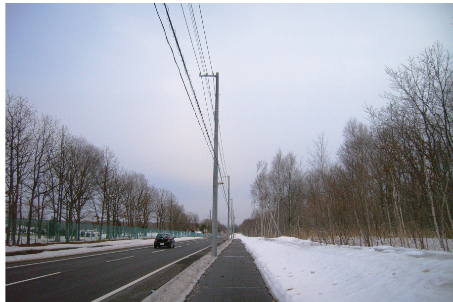
道路敷地外に設置可能と考えられる区間での占用事例。車道に近く衝突事故の危険性も高まる
