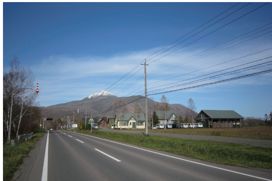
市街地だけでなく郊外部でも通信線の多線化により景観阻害が増している
